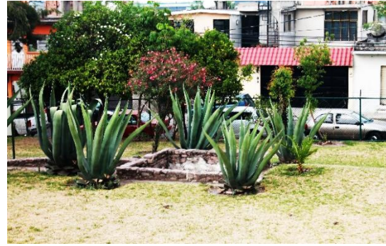
Empedrado en forma de embudo, aquí se concentraba el agua de la lluvia para los cultivos de la hacienda.
