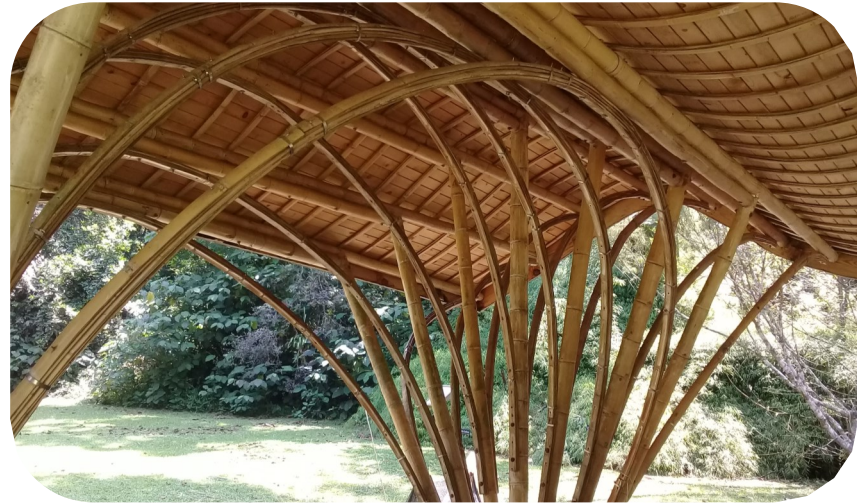
Imagen (163) foto techo ecológico en Sur bambú Huatusco,Ver. Foto propia.
