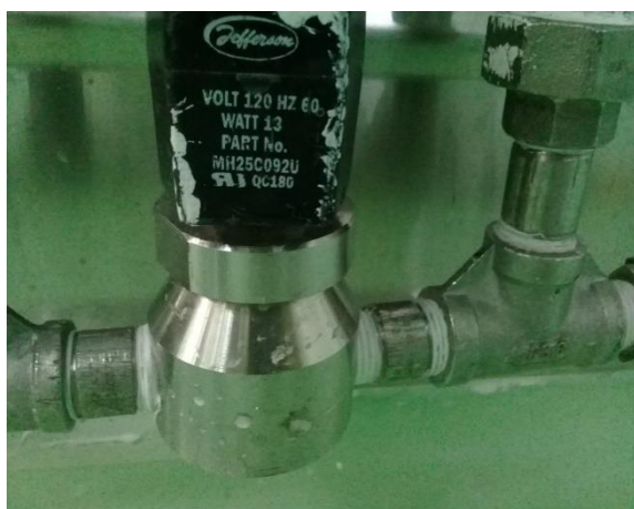
Img.49 electroválvula de condensados
