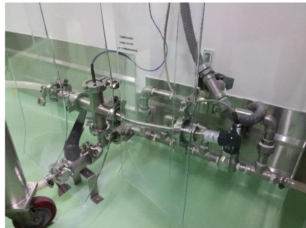
Img. 67 inspecciones de conexiones en dren.
