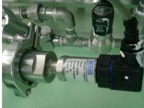
Img.52 válvula con conexión Clamp
