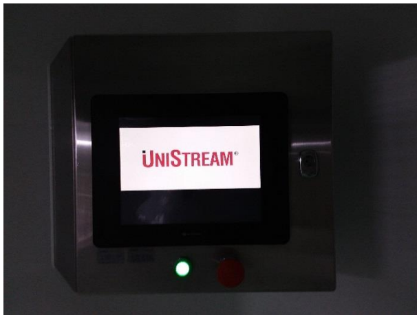
Img. 68 se energiza Panel.
