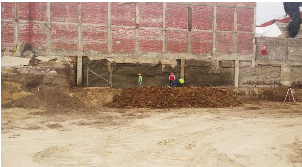
Construcción de muretes según MS
