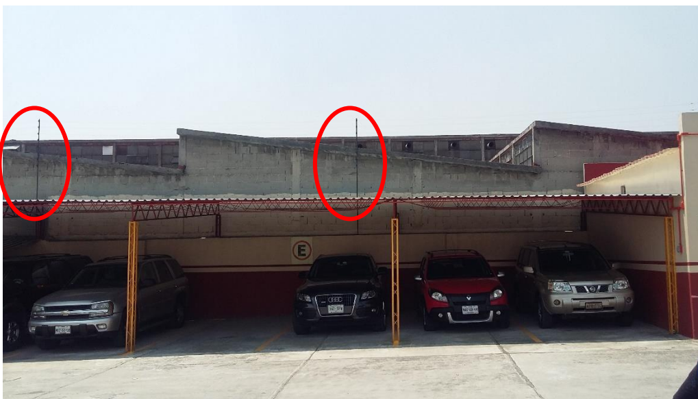
(MALLA ELECTRIFICADA AL NORTE DEL PREDIO)
