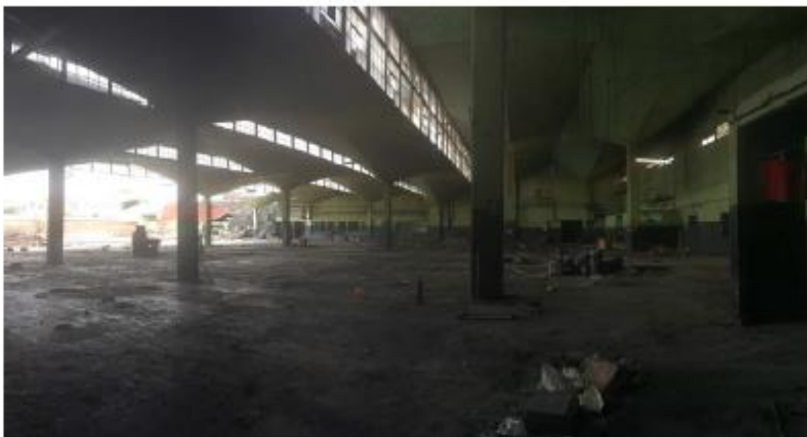
Fig.4.- Cascarones a demoler y sector 9 al Fondo..
