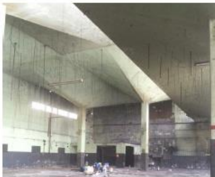
Fig.1.- Cascarones Hiperbólicos Invertidos a demoler.
