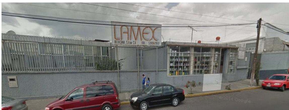
(ANTIGUA FACHADA FABRICA LAMEX S.A. DE C.V. 2015)
