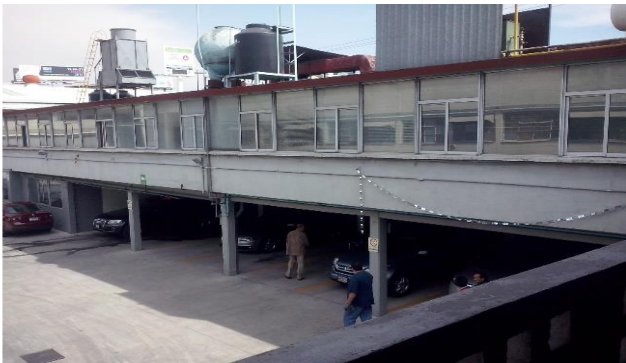
Estado físico del predio antes del inicio de los trabajos 2/2
