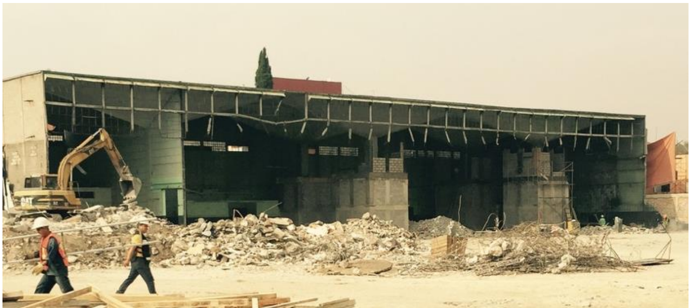
Construcción de apuntalamientos en columnas
