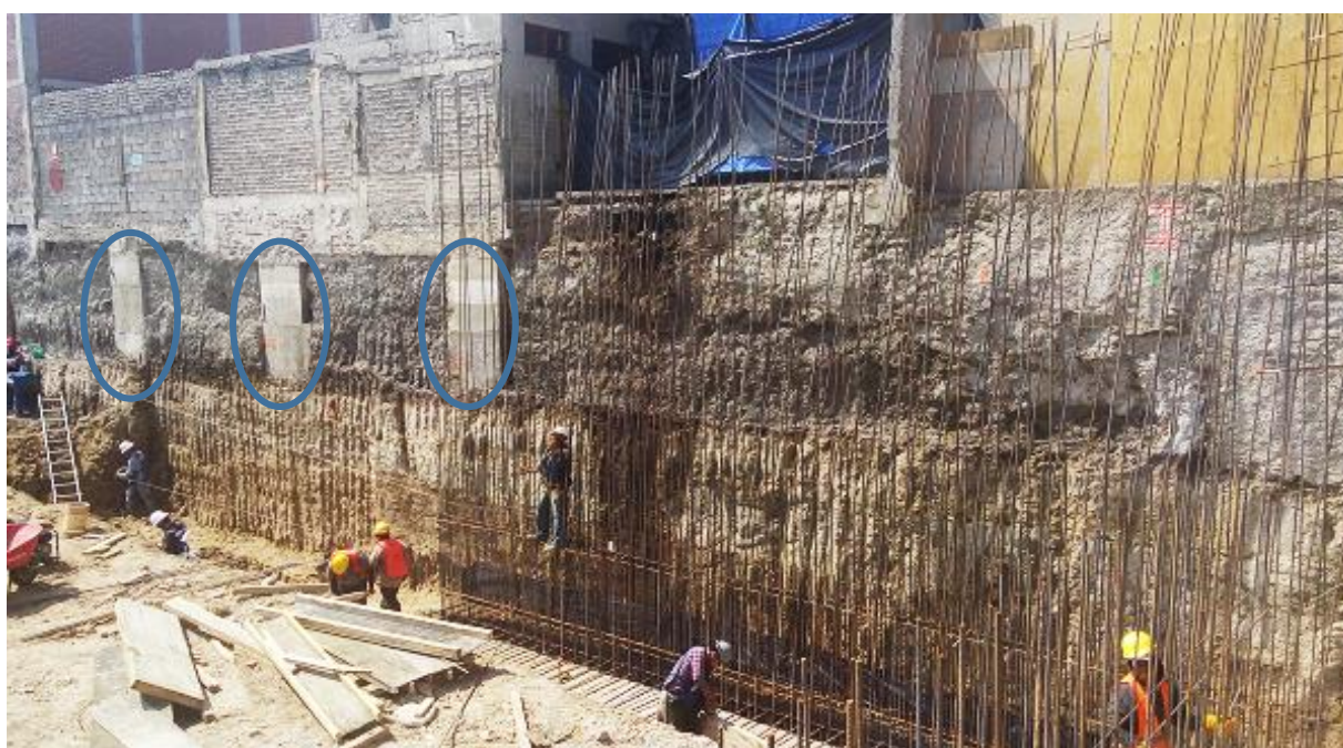
Construcción de muretes según MS
