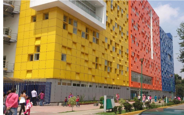
Fachada Calle Dr. Márquez (Vista Oriente a Poniente)
