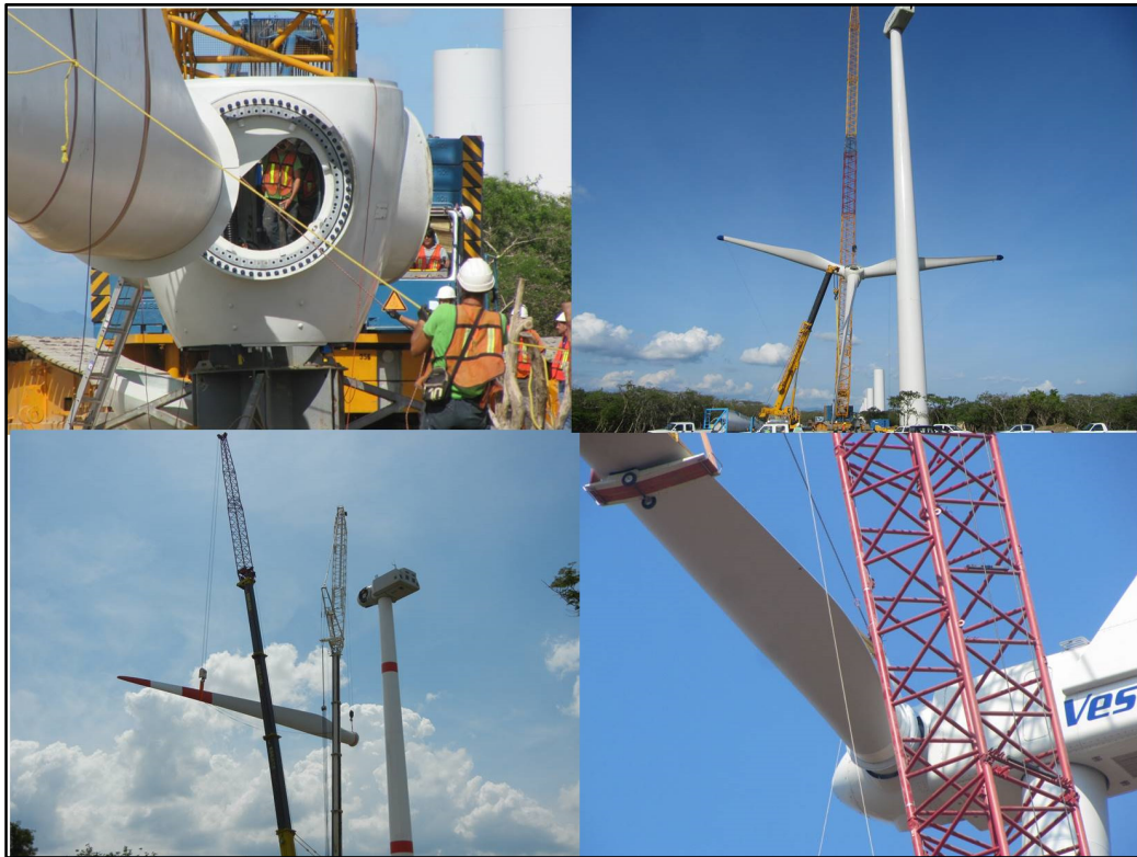
Foto 23.- Armado de rotor
