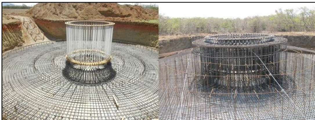
Foto 8.- Colocación de corona de pernos
