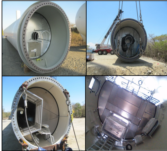
Foto 14.- Interior de secciones de torre
