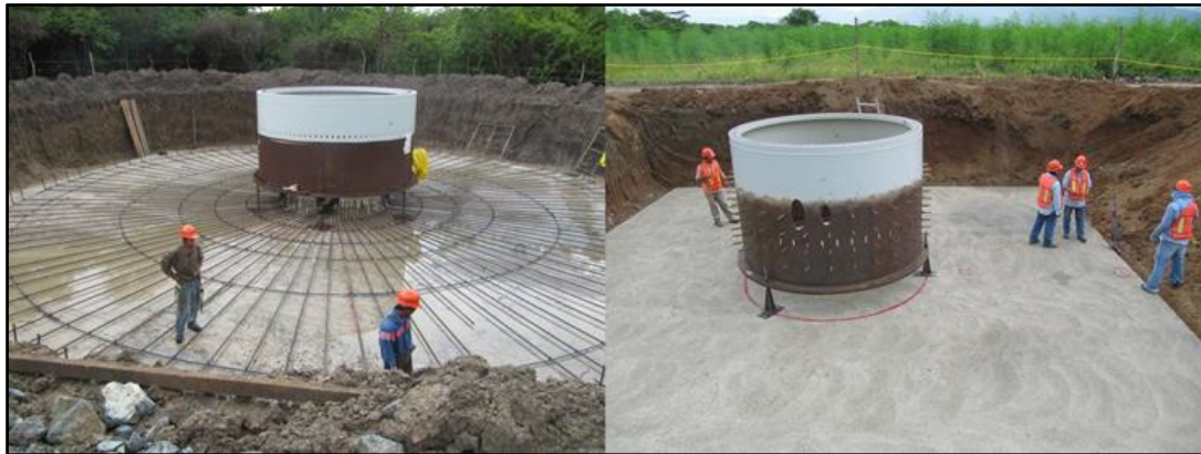
Foto 7.- Colocación de virola
