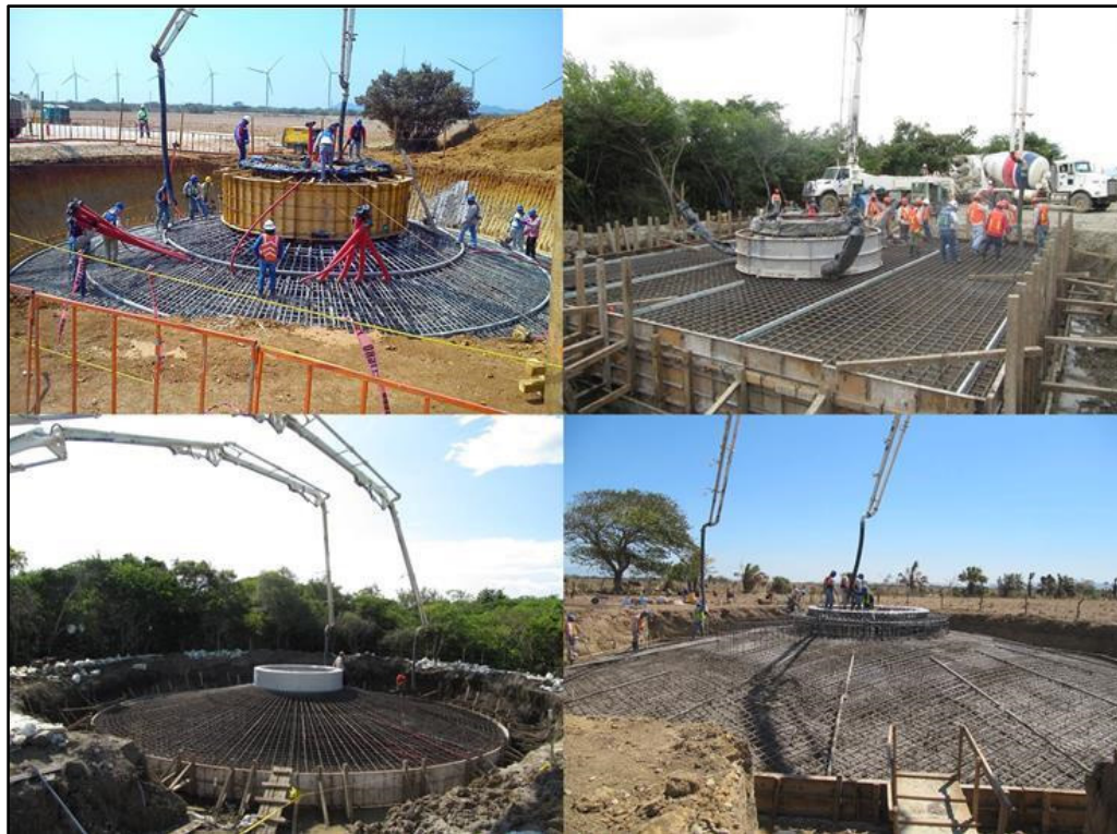
Foto 6.- Colado de cimentaciones
