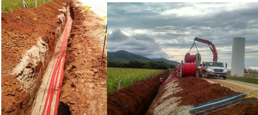
Foto 4.- Colocación de cable media potencia
