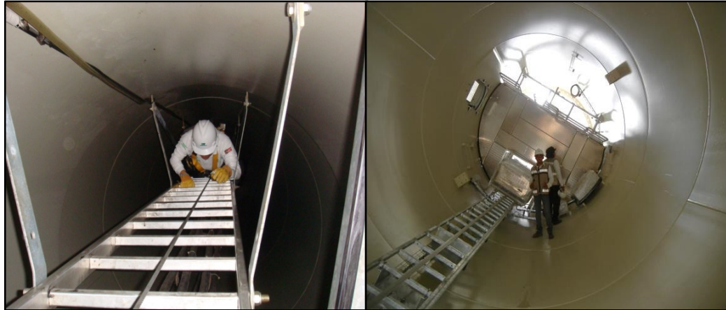
Foto 16.- Cable de seguridad
