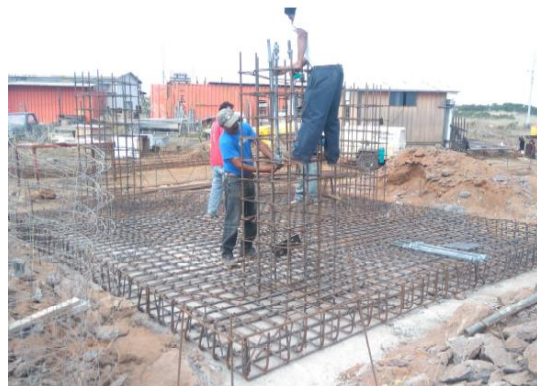
Foto No. 4. Habilitado de acero
