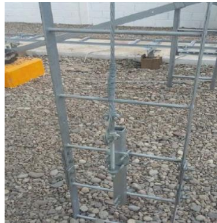
Foto No. 22. Escalera de ascenso
