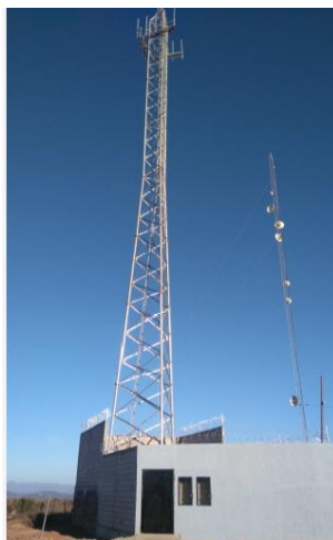
Foto No. 23 Montaje total de torre
