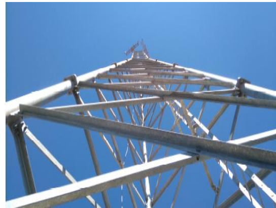
Foto No. 16. Celosía de torre
