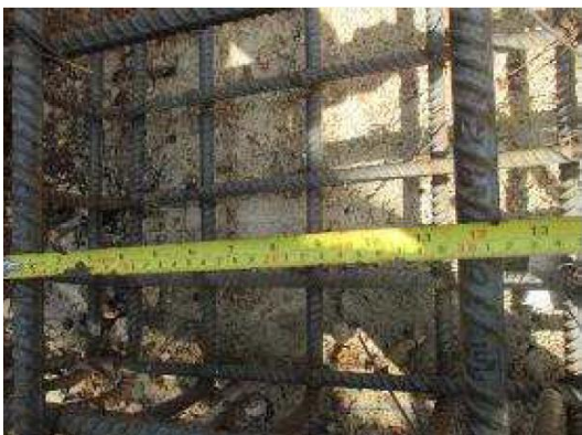
Foto No. 5. Separación de acero
