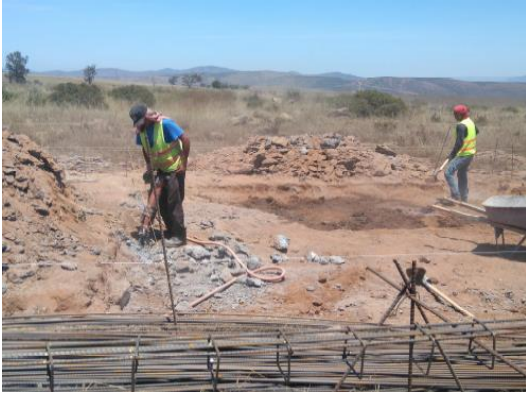
Foto No. 1. Trazo y nivelación
