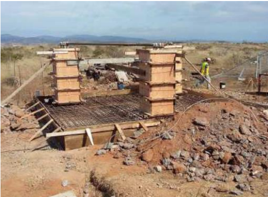
Foto No. 7. Colocación de Cimbra
