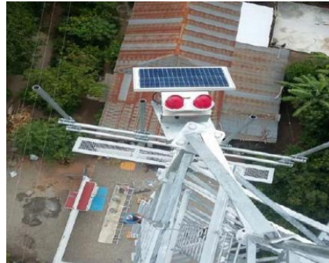
Foto No. 20. Luces de obstrucción
