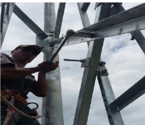
Foto No. 17. Apriete de tornillería
