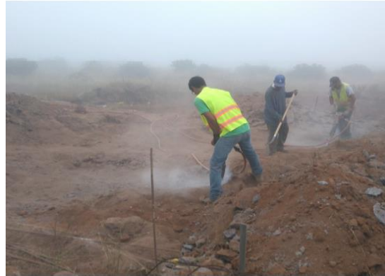
Foto No. 2 Excavación
