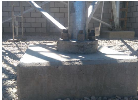
Foto No. 14. Grout en dado
