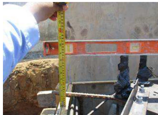
Foto No. 6. Nivelación de anclas
