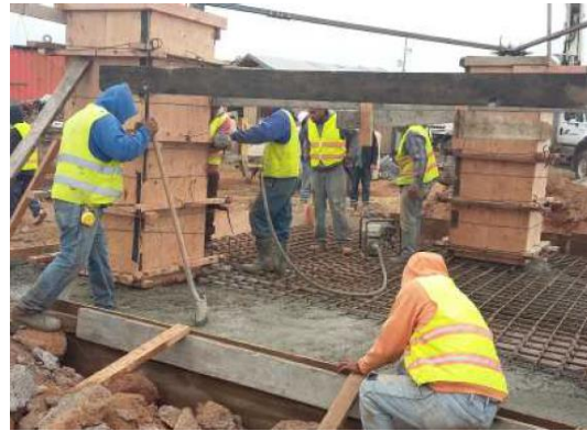
Foto No. 10. vibrado de concreto
