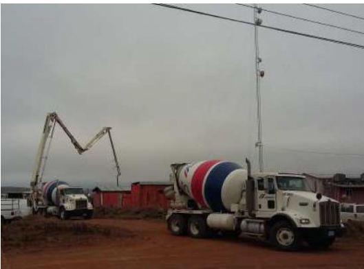
Foto No. 9. Bombeo de concreto
