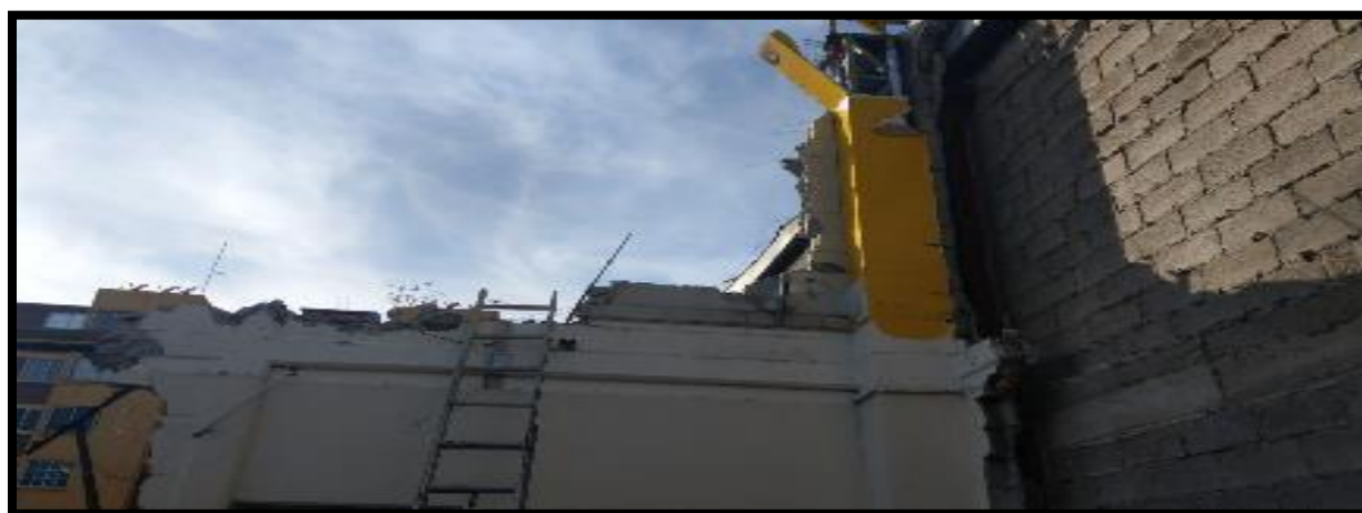
Imagen 3-7 Demolición de losa de concreto de 15 cm de espesor. Fuente: TOBSA Ingeniería Civil S.A. De C.V.
