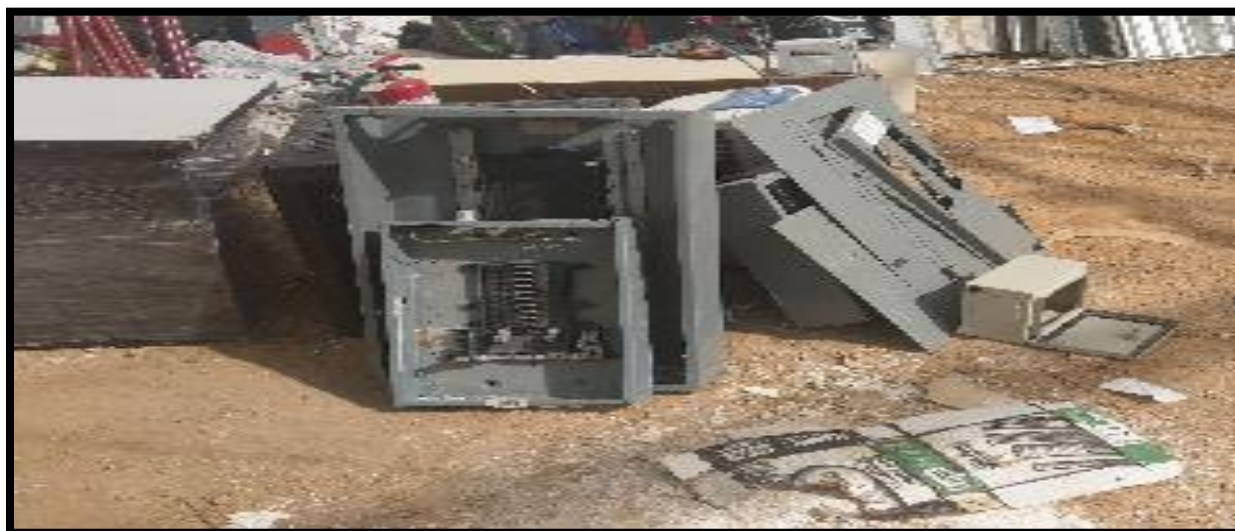
Imagen 3-5 Desmantelamiento y recuperación de tableros eléctricos. Fuente: TOBSA Ingeniería Civil S.A. De C.V.
