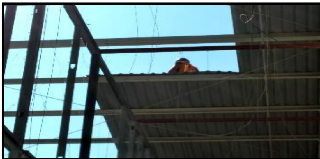
Imagen 3-3 Desmantelamiento de cubierta de lámina. Fuente: TOBSA Ingeniería Civil S.A. De C.V.
