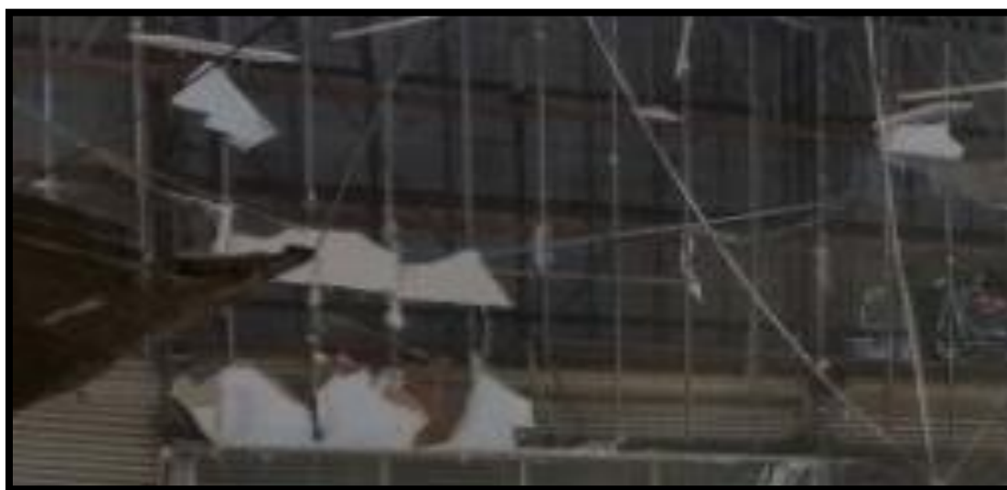
Imagen 3-2 Desmantelamiento de lambrines. Fuente: TOBSA Ingeniería Civil S.A. De C.V.
