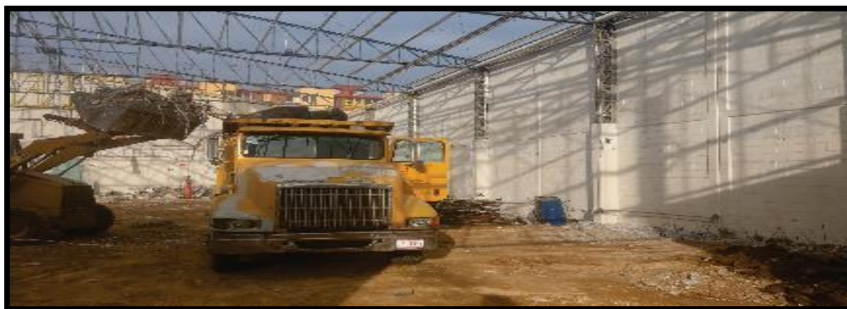
Imagen 3-9 Acarreo de material producto de la demolición y llevado al tiro oficial más cercano. Fuente: TOBSA Ingeniería Civil S.A. De C.V.
