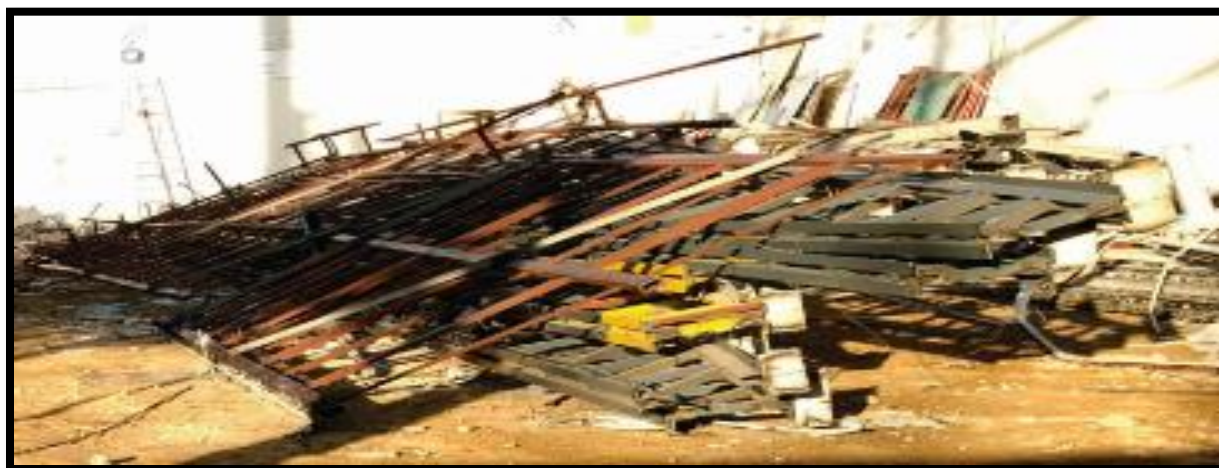
Imagen 3-4 Desmantelamiento de estructura metálica, incluye largueros para cubierta, armaduras para cubierta, columnas a base de perfil en forma de ángulo. Fuente: TOBSA Ingeniería Civil S.A. De C.V.
