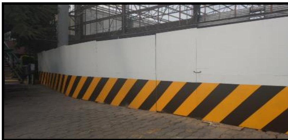
Imagen 3-1 Colocación de tapial perimetral. Fuente: TOBSA Ingeniería Civil S.A. De C.V.
