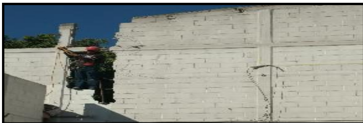
Imagen 3-8 Demolición manual de muros de mampostería con block de 15x20x40 cm. Fuente: TOBSA Ingeniería Civil S.A. De C.V.
