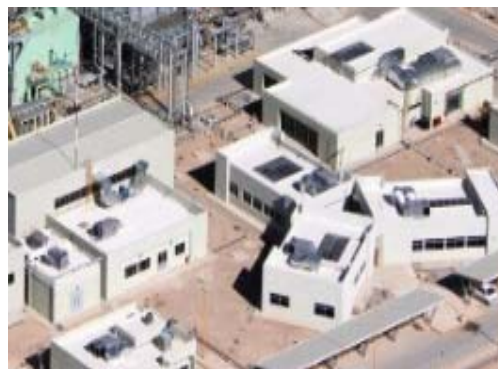
Fotografía 2 avance en la construcción de edificios arquitectónicos incluye el edificio administrativo
