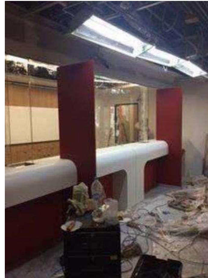
Fig 41. Foto de instalación en proceso de mostradores, incluyendo cristales de 9mm entintados.
