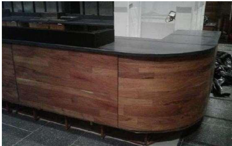
Fig. 33. Fotos de una sucursal CORE en proceso de instalación. Los gabinetes se fabricaron en MDF con laminado plástico, las cubiertas son de superficie sólida Corian y paneles frontales de tzalam curvo.
