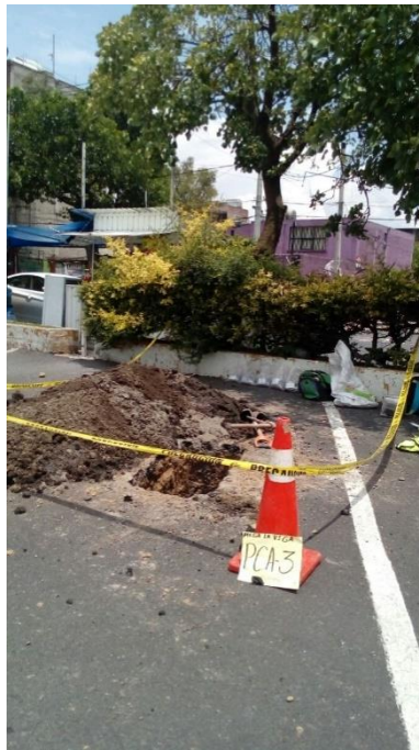
FOTOGRAFÍAS 2.8 2.9, 2.10 Y 2.11.- TRABAJOS DE POZOS A CIELO ABIERTO REALIZADOS
