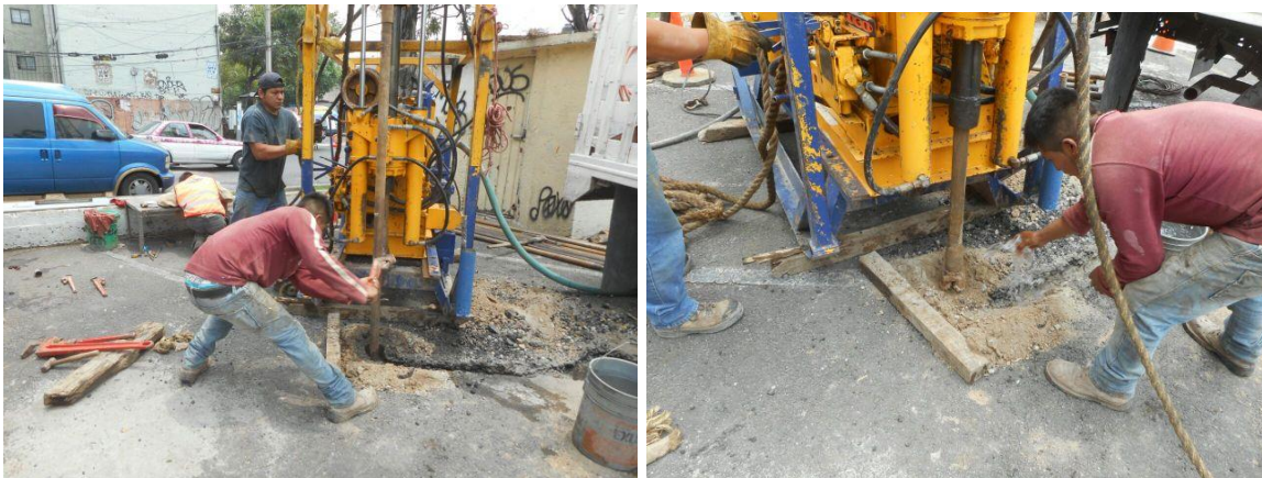
FOTOGRAFÍAS 2.1 Y 2.2.- MAQUINARIA UTILIZADA EN EXPLORACIÓN
