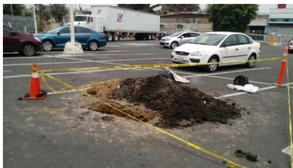
FOTOGRAFÍA 2.3.- EXCAVACIÓN DE PCA 1
