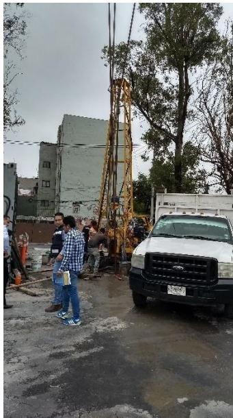
FOTOGRAFÍAS 2.4, 2.5, 2.6 Y 2.7.- MONTAJE DEL EQUIPO PARA REALIZAR LOS SONDEOS MIXTOS
