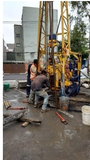
FOTOGRAFÍAS 2.4, 2.5, 2.6 Y 2.7.- MONTAJE DEL EQUIPO PARA REALIZAR LOS SONDEOS MIXTOS
