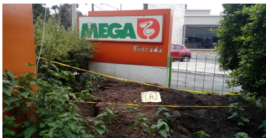
FOTOGRAFÍA 2.12.- EXCAVACIÓN DE PCA 3
