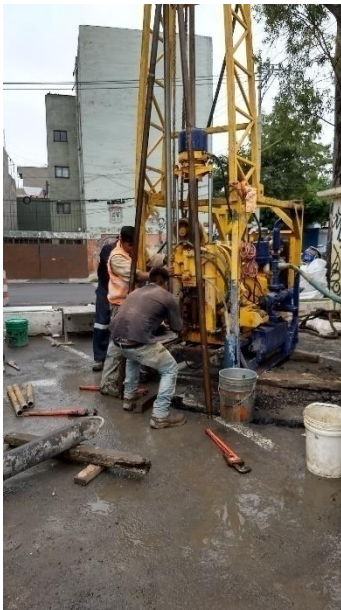
FOTOGRAFÍAS 2.4, 2.5, 2.6 Y 2.7.- MONTAJE DEL EQUIPO PARA REALIZAR LOS SONDEOS MIXTOS
