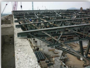
Ilustración 43. Conexión de Joist.
