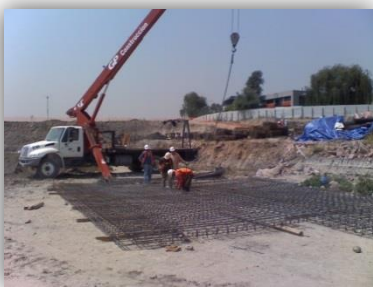
Ilustración 24. Armado de muro.
