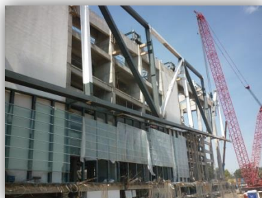
Ilustración 56. Acero en fachadas.
