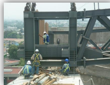
Ilustración 38. Conexión de Brunel.
