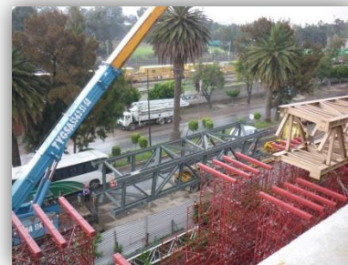
Ilustración 39. Armado de Brunel.
