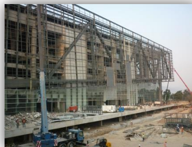
Ilustración 57. Armado en fachadas.
