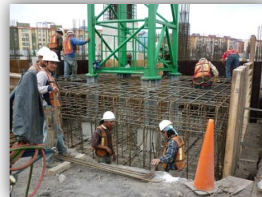
Ilustración 33. Cimiento de Grúa.
