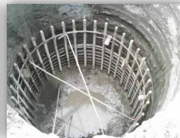
Ilustración 15. Colado de pila.
