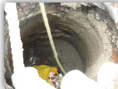
Ilustración 30. Drenaje Av. Granjas.
