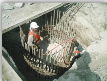
Ilustración 16. Descabece de pila.
