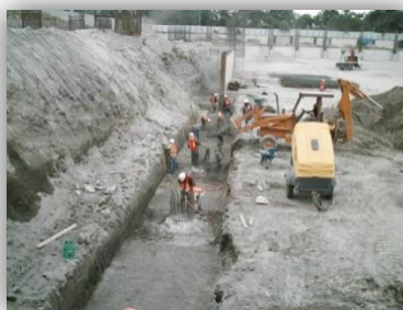
Ilustración 17. Descabece de pila.
