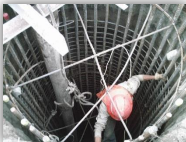
Ilustración 13. Colado de pila.
