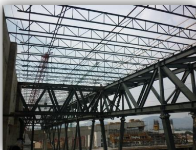
Ilustración 41. Armaduras Joist.
