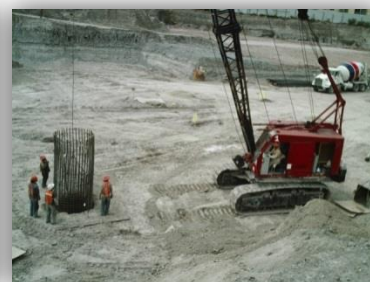
Ilustración 12. Colocación de pila.
