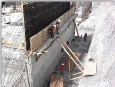
Ilustración 25. Cimbra en muro.
