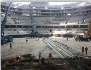
Ilustración 35. Pista Edif. Arena.
