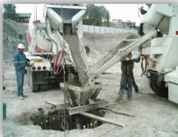
Ilustración 14. Colado de pila.
