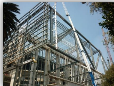
Ilustración 45. Volado en fachada.
