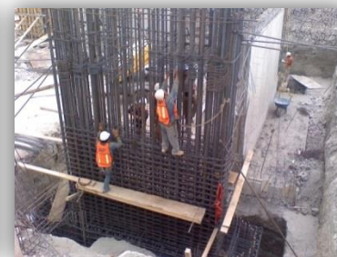
Ilustración 18. Armado de columna.
