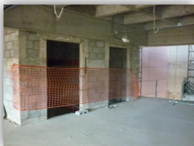
Ilustración 76. Cubos de ascensores.
