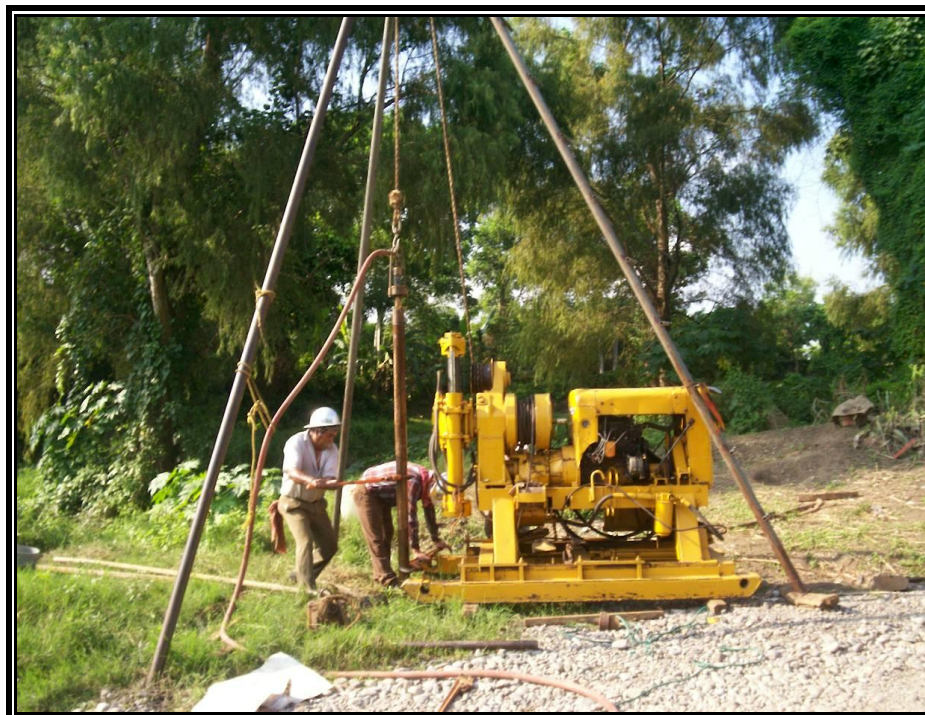
Figura 11. Acercamiento de máquina en el sondeo 2.
