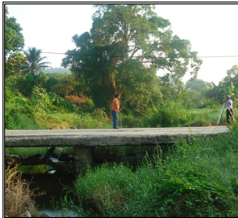
Figura 21. Nivelación del fondo aguas abajo.
