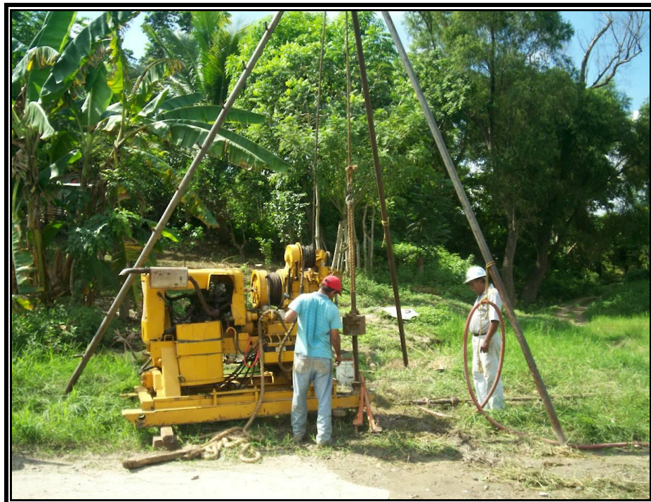
Figura 9. Acercamiento de máquina en el sondeo 1.
