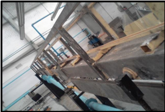
Figura 3.3 CFU en proceso de ser despintado.
