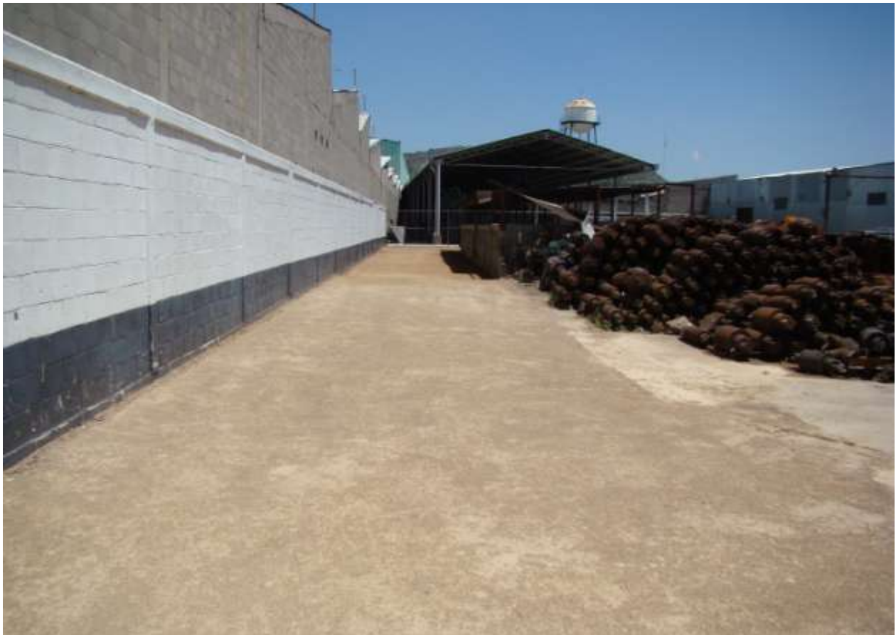
Figura 2.4.- Limpieza y nivelación de terreno detrás de cubículos de chatarra
