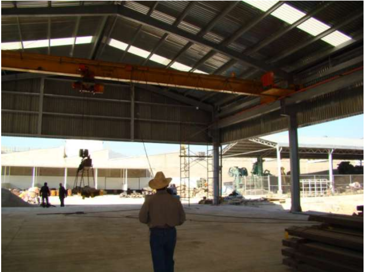
Figura 3.2.- Prueba de grúa en nueva sección de almacén de materia prima.
