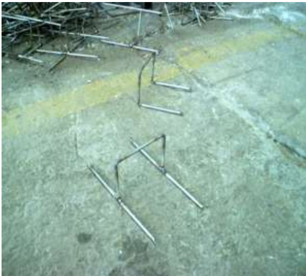
Figura 1.7.- Anclas dobles intermedias y sencillas para los extremos
