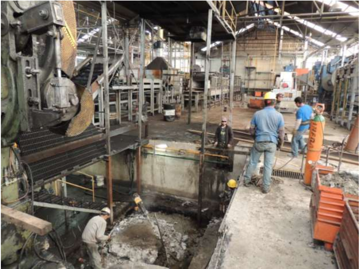
Figura 5.1.- Preparación de piso de fosa de tina de temple para equipo nuevo.
