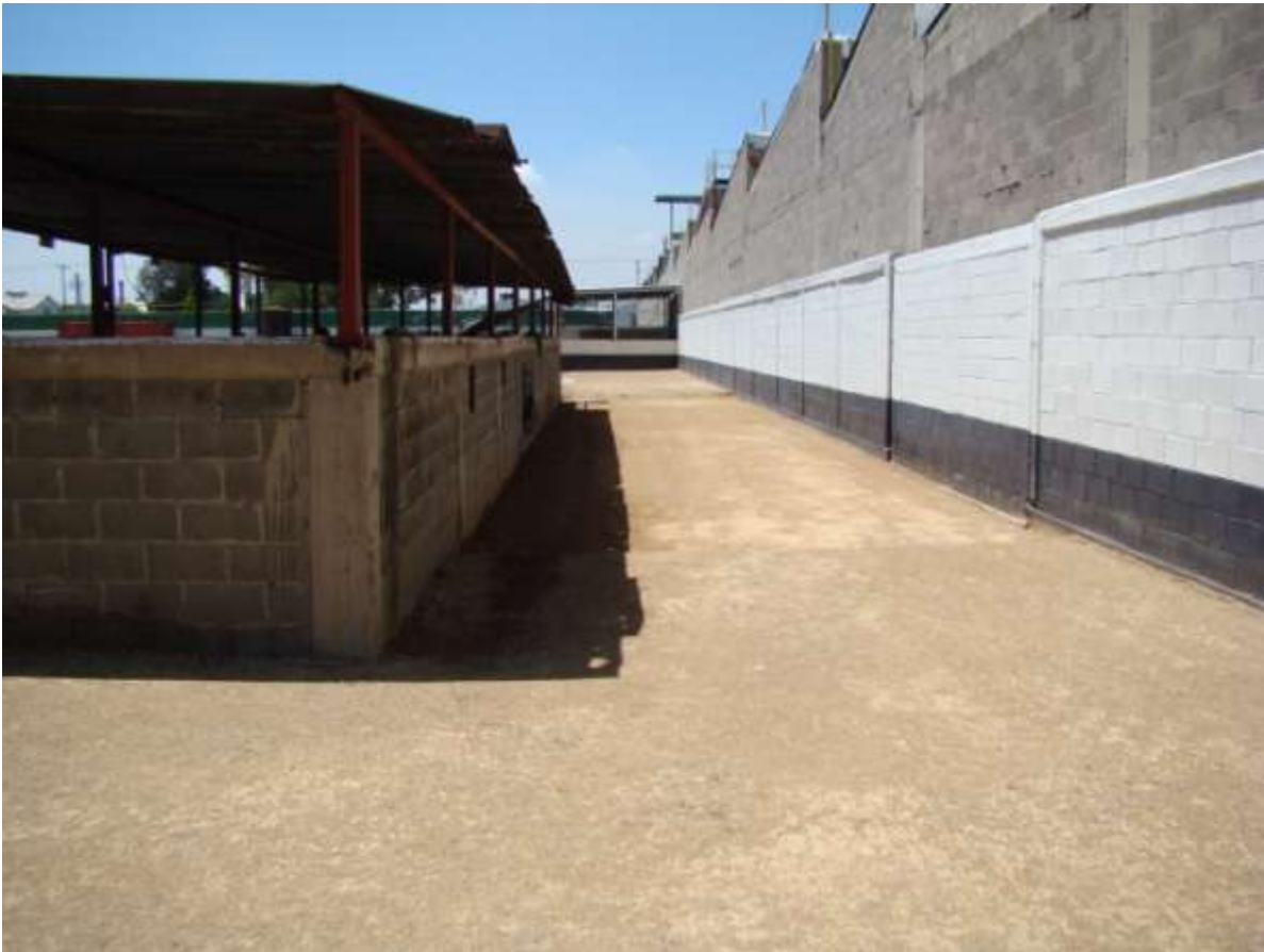
Figura 2.5.- Cubículos de chatarra antes de ser demolidos
