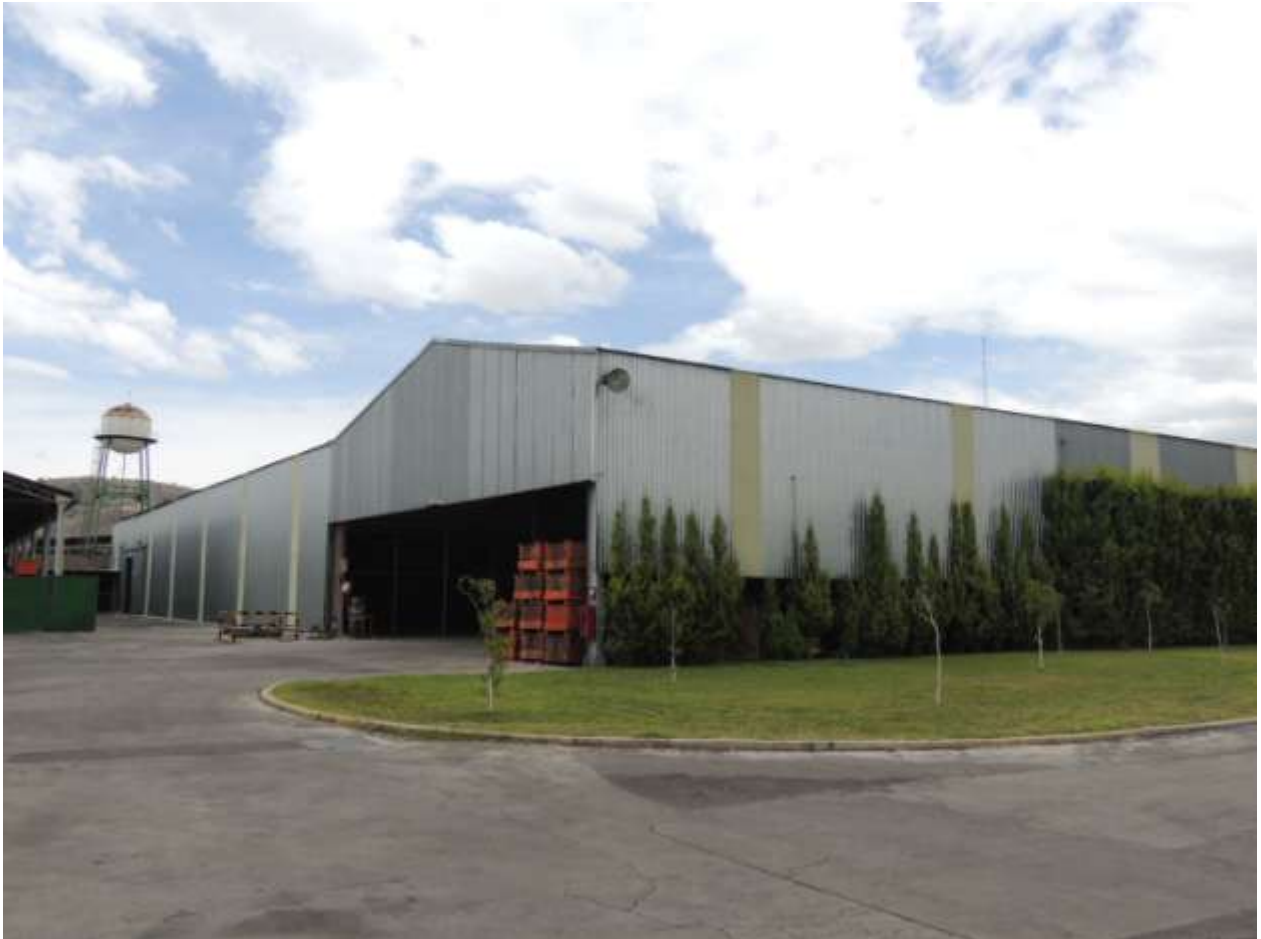
Figura 3.5.- Nave No. 4 y Ampliación de nave de materia prima terminadas.
