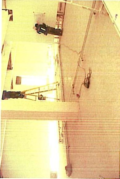
TRAMO 1 - tubería de 51mm fijada a piso, cajas de 30x30
