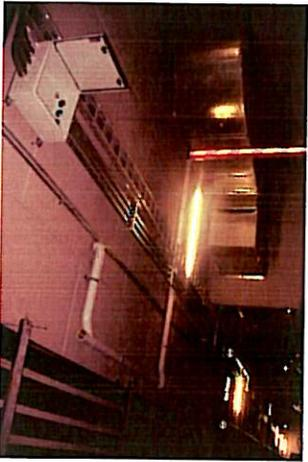
TRAMO 13, tubería de 51mm, tubería flexible licuatite 51mm, fijada con soportería a losa, registro de 50x60.
