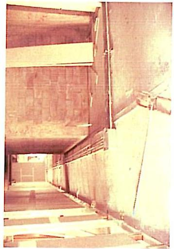
TRAMO 8, tubería de 51mm fijada con soportería a losa, tubería flexible licuante de 51mm
