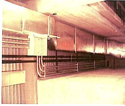
TRAMO 4, tubería de 51mm, soporteria a techo fijada con mordaza, registro 50x60.
