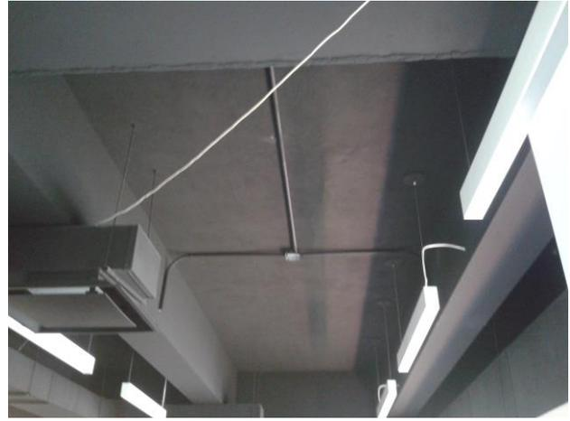
Por esta tubería pasará el cable de cctv, como se puede observar hay un ducto de aire, luminarias y el acabado que fue solo pintado de color negro.
