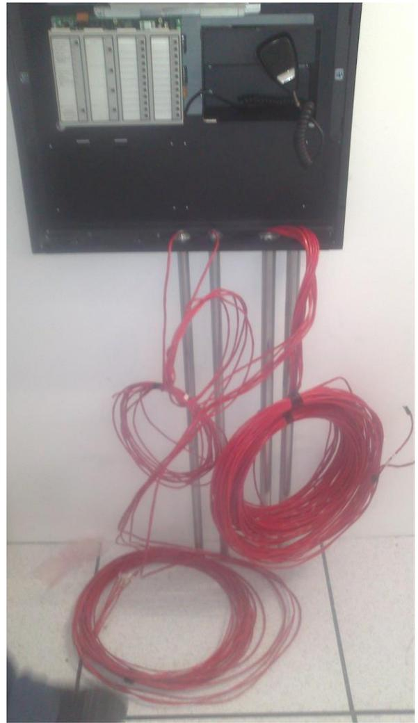
Este panel fue montado en una muro con de concreto armado ya que este tipo de equipos son muy pesados y en un muro de tabla roca no soportaría el peso de este a menos que se reforzará para que se colocara este equipo, pero al ser una sitio terminado se optó por ponerse en un muro de concreto armado para que soporte el peso de este.
