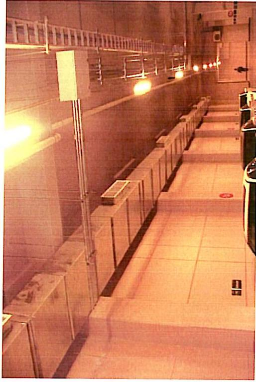
TRAMO 18, tubería de 51mm, fijada con soportería a losa, registro de 50x60.
