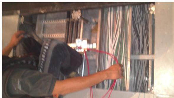
En la fotografía de la parte izquierda se colocó la tubería en plan fon, en la fotografía del lado derecho se puede observar que no se puede realizar el trabajo tan rápido ya que hay otro sistema que pasa por donde se trazó el recorrido del sistema de SDH.
