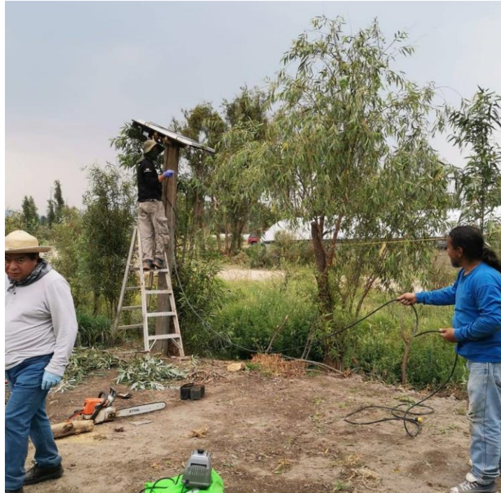
Figura 5. Colocación del panel solar.
