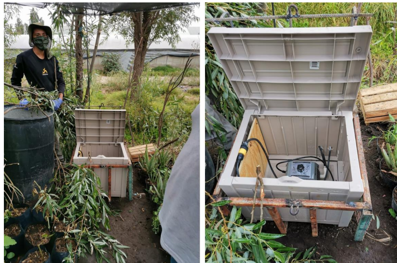
Figura 6. Colocación de la caja protectora del compresor de aire
