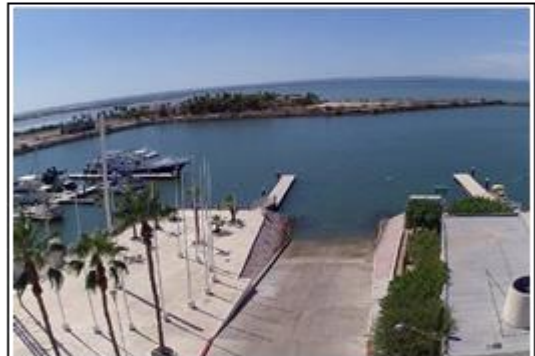
RAMPA DE BOTADO
