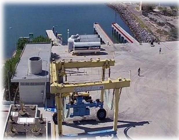
Figura 6. Estación de servicio, edificio, área de despacho, travel lift patio de maniobras.
