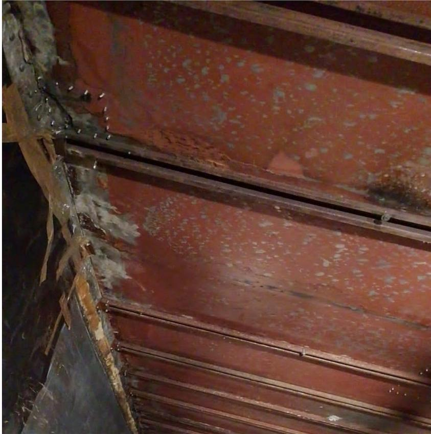
Figura 11. Techo con fisuras, filtraciones de luz y humedad que fue rechazada por riesgo de carga.
