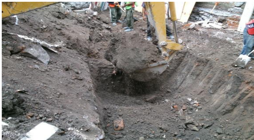
Foto V1.1 Excavación por medios mecánicos en cimentación.
