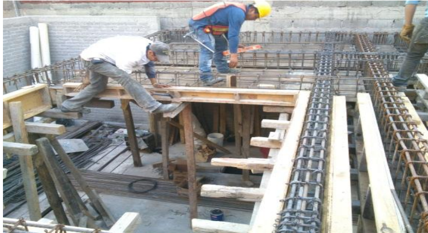
Foto V1.4 Cimbra, habilitado de acero en Trabes cuerpo 2.
