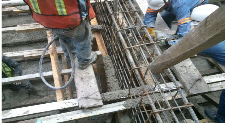
Foto V1.2 Colado de losa fondo de cimentación y contratrabes.
