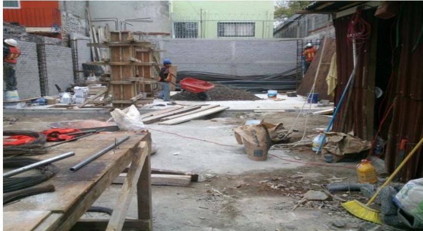
Foto V1.4 Habilitado, cimbrado y colado de columnas en estacionamiento
