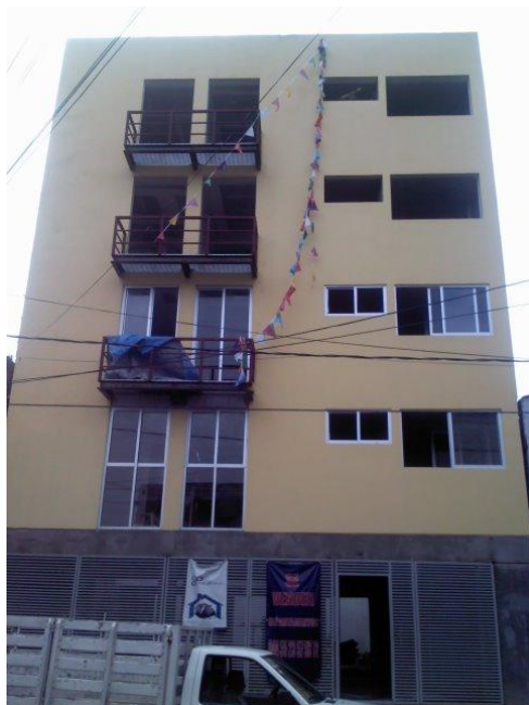
Foto V2.1 Pintura vinílica Fachada principal del edificio, cuerpo 1.
