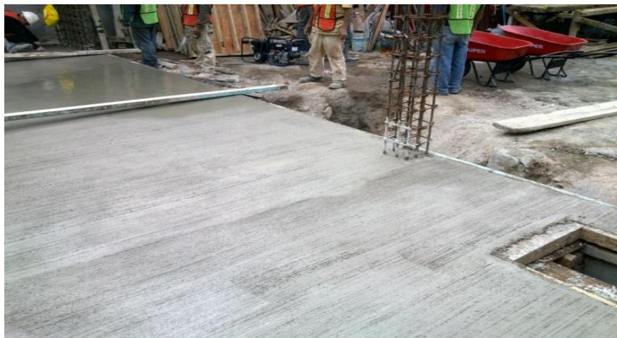
Foto V1.3 Losa tapa de cimentación cuerpo 2.
