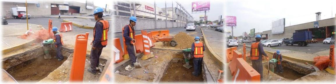
Figura. G .Relleno Compactado de Excavaciones. Cortesía de IACMEX/TECSA 2014.
