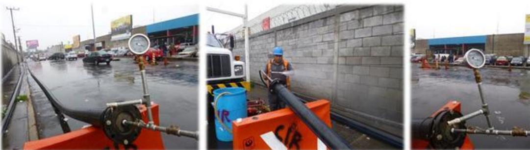
Figura. I. Prueba Hidrostática. Cortesía de IACMEX/TECSA 2014.
