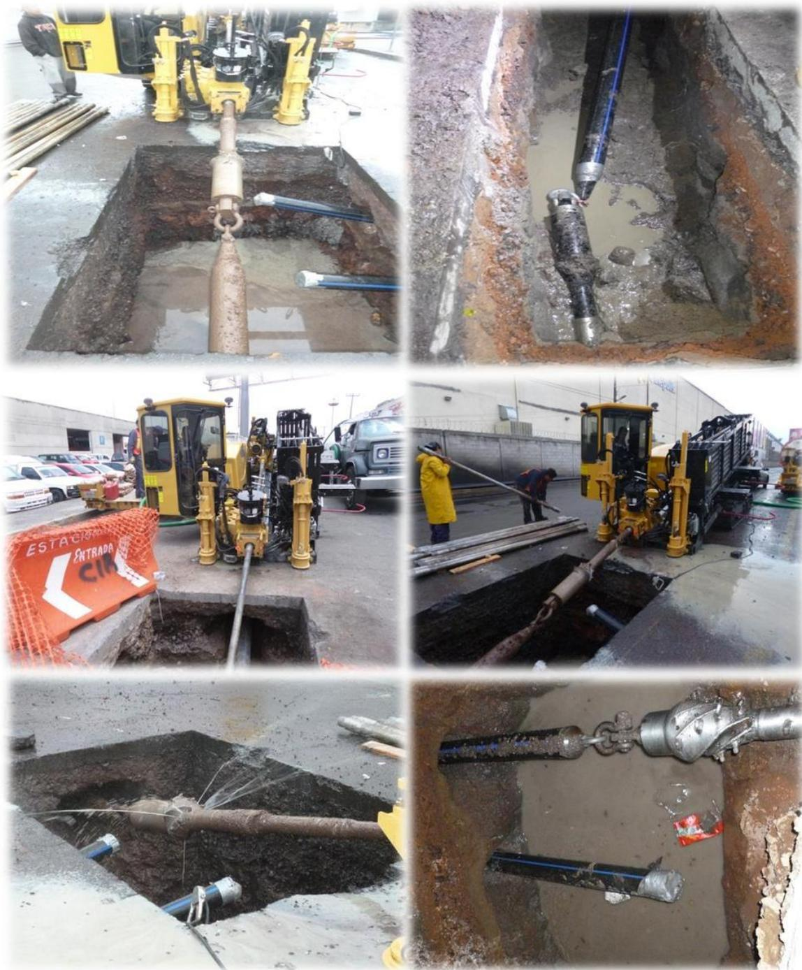
Figura. K. Instalación de Tubería de Agua Potable con el Método de Perforación Direccional Horizontal.
