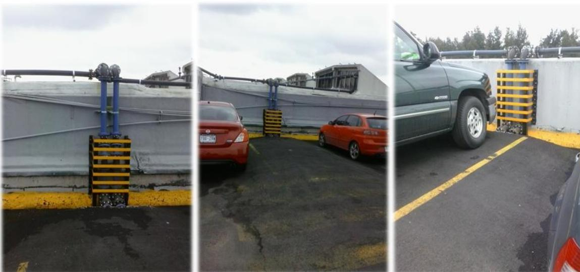
Figura. O. Esquema representativo de las protecciones de la tubería. Cortesía de IACMEX/TECSA 2014.
