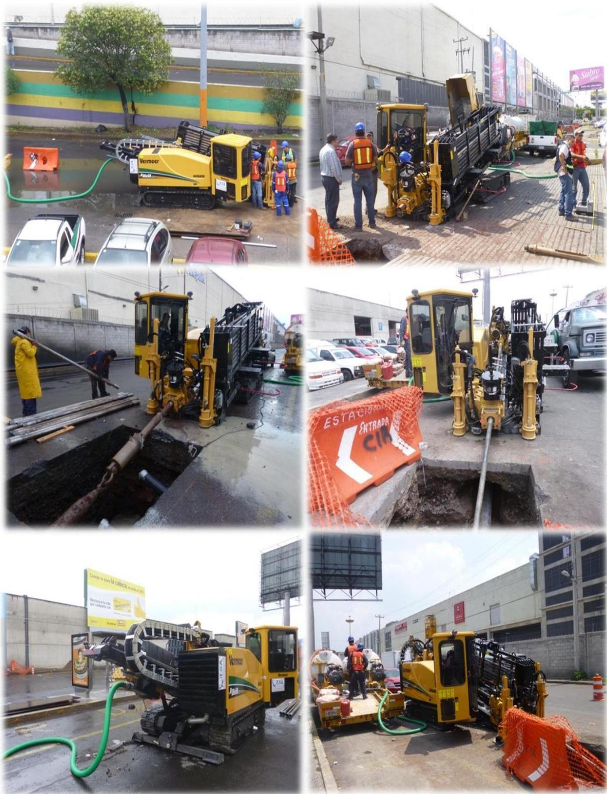
Figura X. Maquinaria Utilizada en la Perforación Direccional Horizontal de la Central de Abasto de la Ciudad de México. Cortesía de IACMEX/TECSA 2014.
