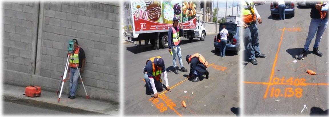
Figura A. Trazo y Nivelación del Proyecto. Cortesía de IACMEX/TECSA 2014.
