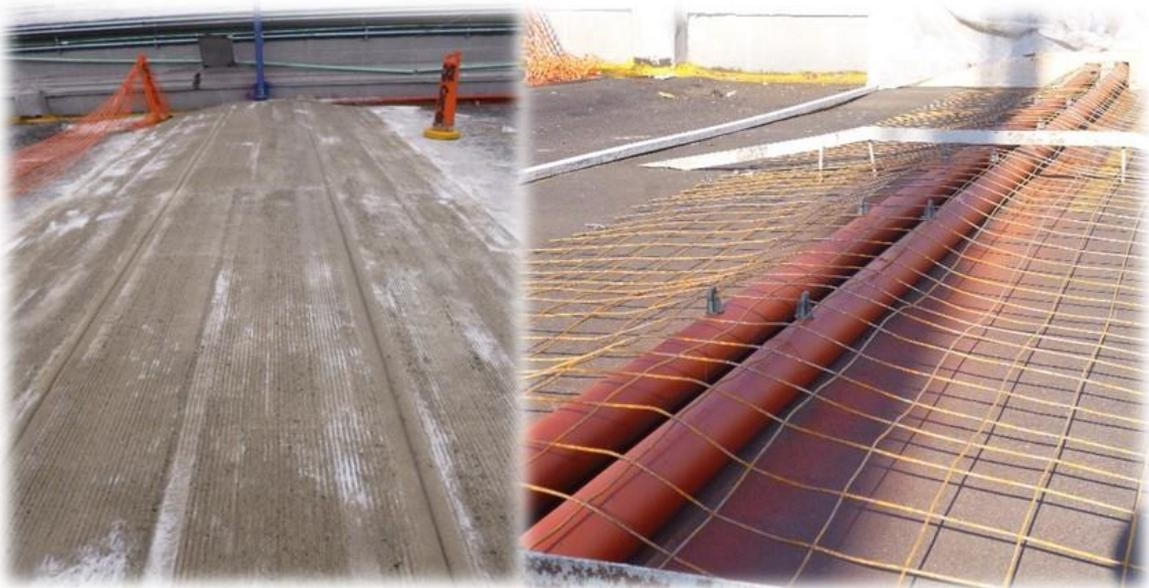
Figura. N. Esquema representativo del tope que protegerá a las dos tuberías de 4+ de acero en el área de estacionamiento aéreo. Cortesía de IACMEX/TECSA 2014.
