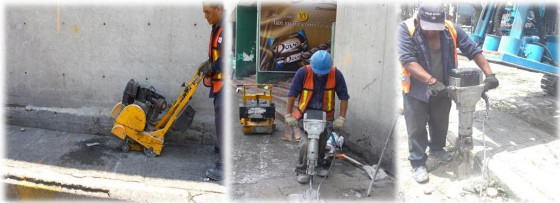
Figura. C .Corte y Demolición de Pavimento, Banquetas y/o Guarniciones. Cortesía de IACMEX/TECSA 2014.
