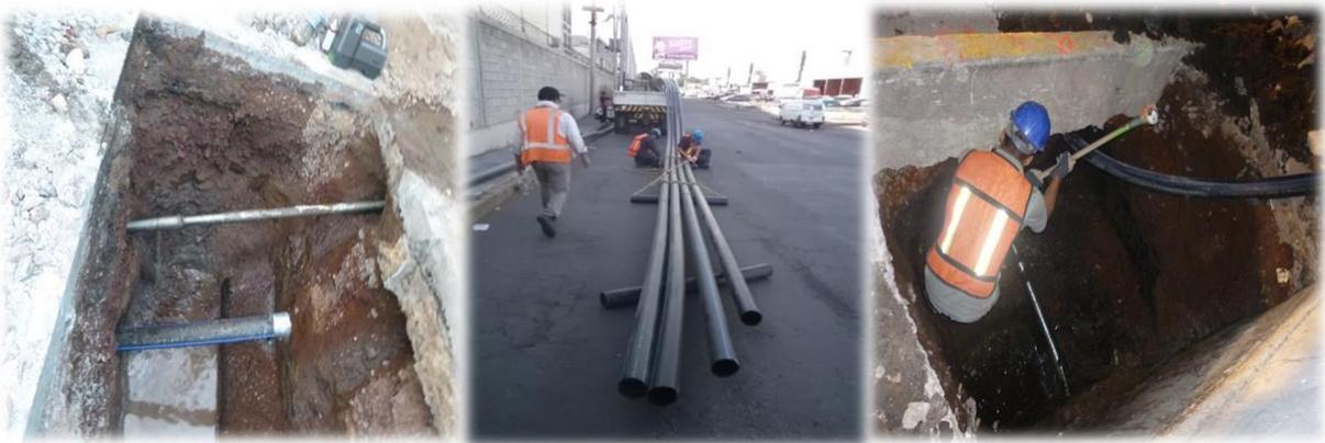
Figura. E. Colocación de Tubería. Cortesía de IACMEX/TECSA 2014.
