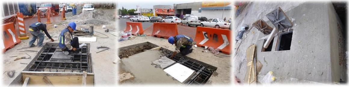
Figura. H .Construcción de Cajas de Válvulas. Cortesía de IACMEX/TECSA 2014.
