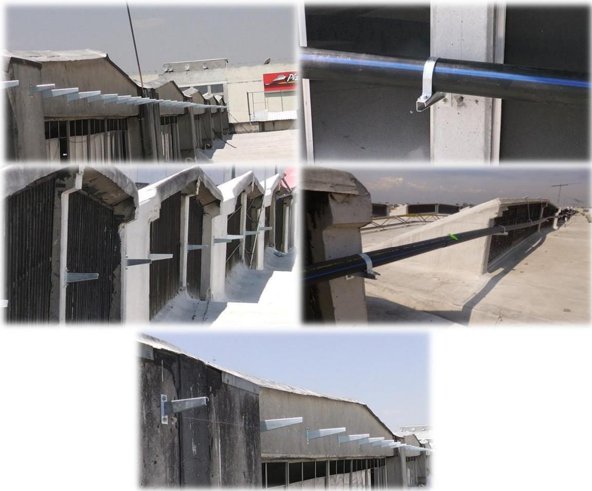
Figura. M. Soportaría para la instalación de la tubería sobre las losas de las naves. Cortesía de IACMEX/TECSA 2014.
