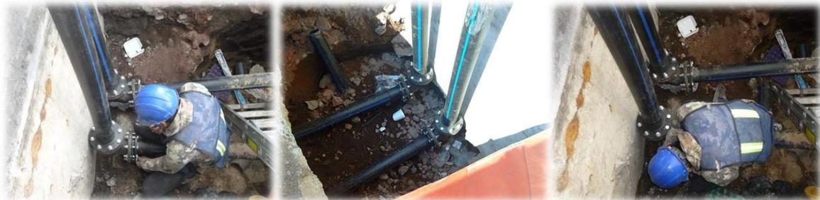
Figura. F. Colocación de Atraques. Cortesía de IACMEX/TECSA 2014.
