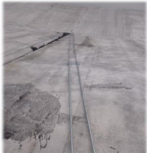
Figura. P. Trayectoria de la tubería de Fo.Ga. Para la Bajada a los Locales Zona de Tragaluces.
