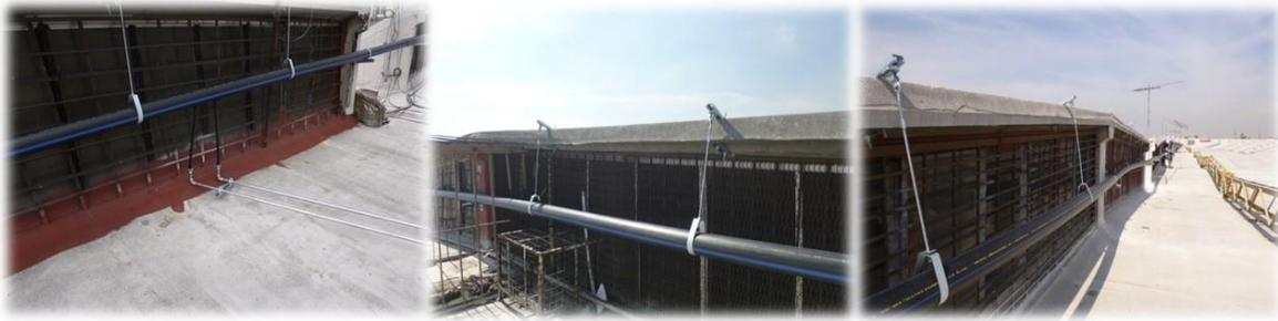
Figura. L. Esquemas representativos de soportaría tipo Pera para la instalación de la tubería sobre las losas de las naves. Cortesía de IACMEX/TECSA 2014.
