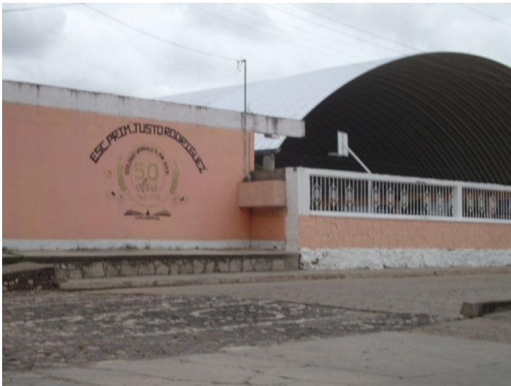
Fachada de la primaria de Yanuitlán.
