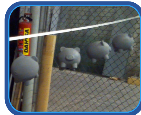
Foto 18: Aplicación de primer gris. Propia. 15-Noviembre-2013.
