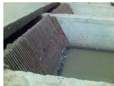
22. Estructura de Cribado
