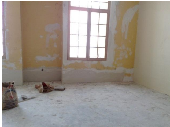
Elaboración de Trabajos de Reparación.
