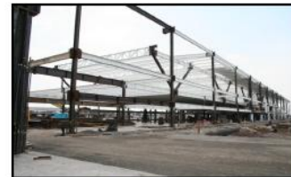
ARMADURAS Y COLUMNAS BIFURCADAS SEMANA N° 19
