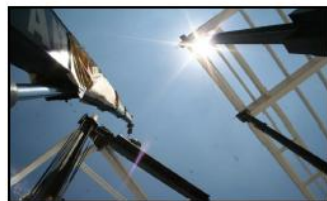
TRABES METÁLICAS NIV. + 15.00 SEMANA N° 21
