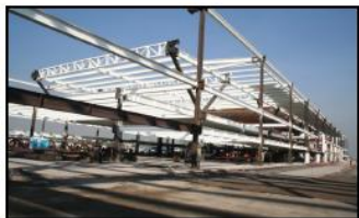
TRABES Y ARMADURAS MONTADAS SEMANA N° 17
