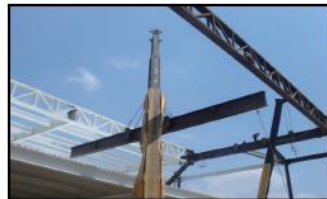
MONTAJE DE TRABE METÁLICA SEMANA N° 18
