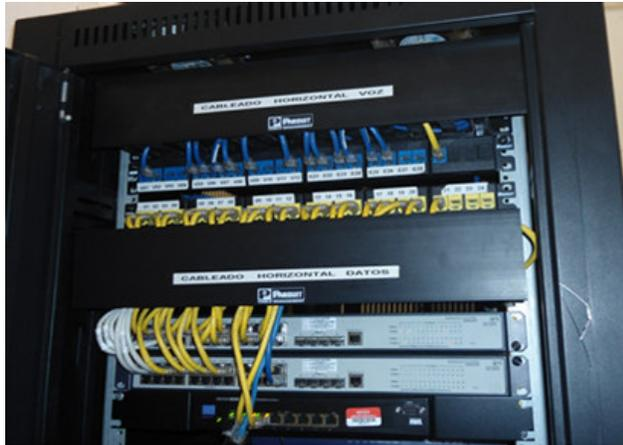
Para entregar los servicios en el área de trabajo de cada colaborador, se armó una LAN con cable UTP Cat 6 para obtener una red de hasta 1 Gbit/s y se instalaron face plates y patch cords identificados en cada oficina. Se utilizó la Norma TIA/EIA-606 la cual especifica un esquema de administración uniforme del cableado en un edificio además de proveer un sistema de información sobre la administración del camino telecomunicación así como espacios y medios independientes.
