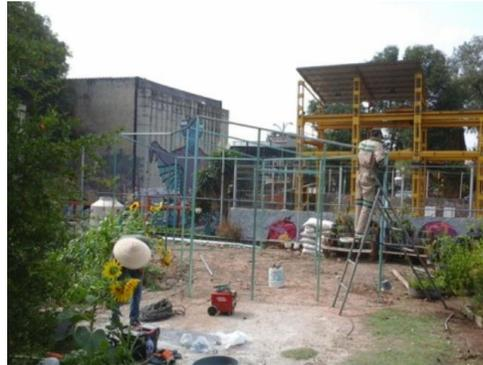
Imagen 13. Colocación y soldadura de invernadero.
