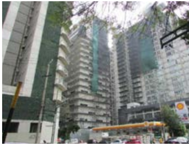
Imagen 26. Torres de departamentos City Towers (Xoco). Fuente: Tomada por Delgadillo en Delgadillo, 2021.
