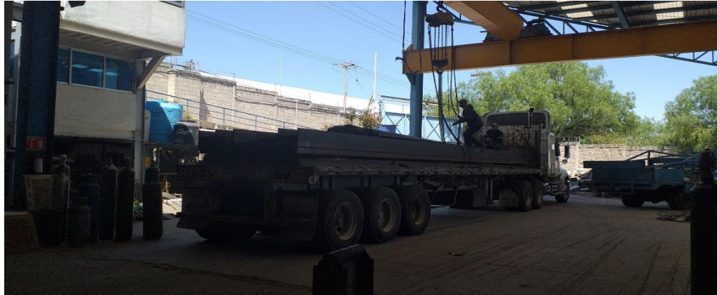
Fig. 4 (Recepción de estructura Metálica de ESTACIONAMIENTO CON CANCHA DE FUTBOL)
