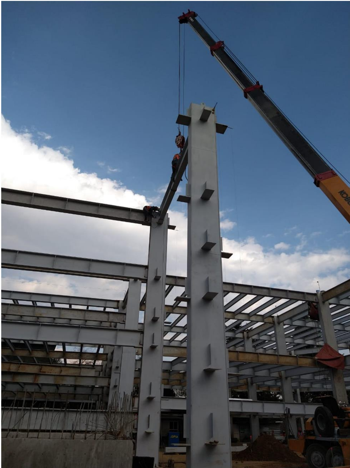
Fig. 1- Montaje de estructura Metálica de ESTACIONAMIENTO CON CANCHA DE FUTBOL
