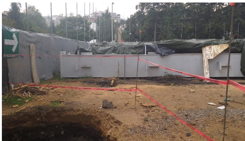
Fig. 14 (Almacenaje en obra)
