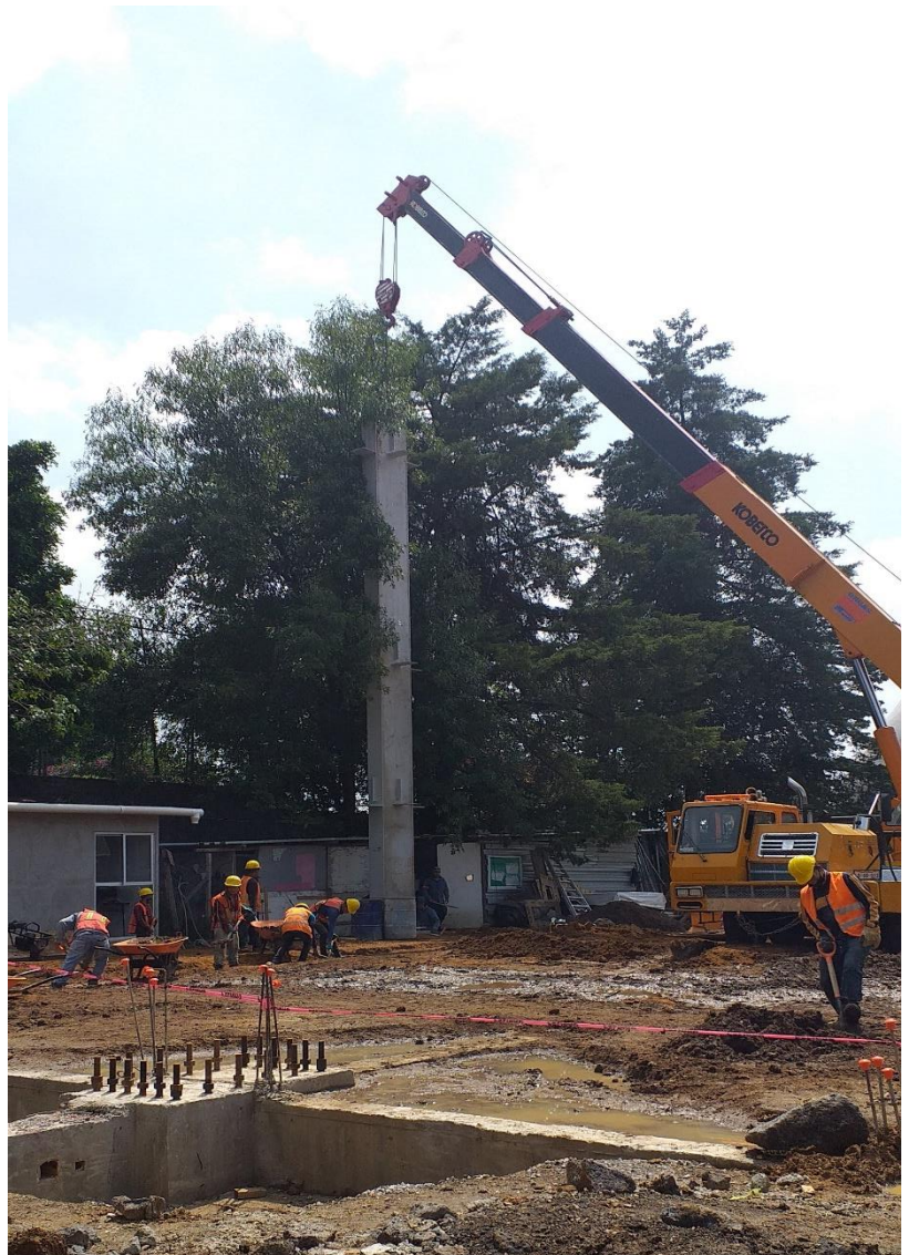
Fig. 15 (Montaje de Columna)
