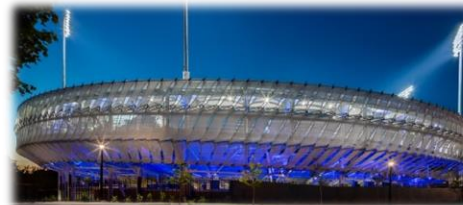
Ilustración 7 Sistema de la cubierta (Arthur Ashe Stadium, 2011)
