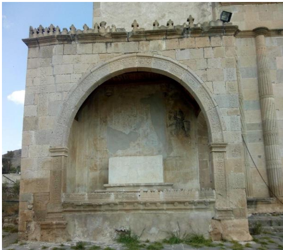
Figura 34. Capilla abierta (Fuente: trabajo de campo)
