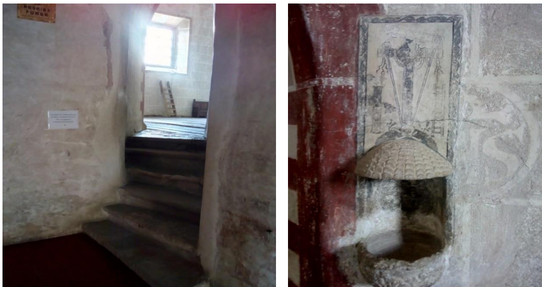
Figura 78. Escalera de acceso al coro en la esquina poniente del claustro alto (Fuente: trabajo de campo)
