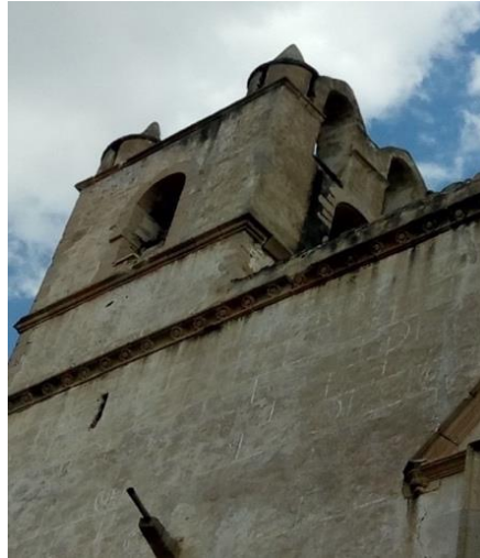
Figura 42. Fachada de la torre (Fuente: trabajo de campo)
