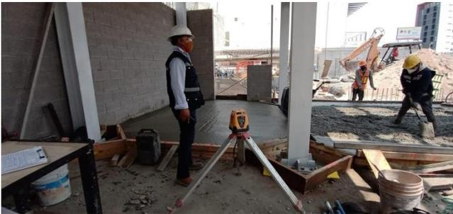
Se colocaron los muros perimetrales para que se pudiera realizar el vaciado de concreto, estaban a plomo para que quedaran completamente verticales y en forma correcta. Se continuó con los trabajos que mencione anteriormente del vaciado de concreto en el área de mezzanine y parte de planta baja, colocándose las madrinas, grout en columnas y cimbra, todo esto una vez compactado el terreno y nivelado. Se tenía un topógrafo encargado de los niveles para que no tuviéramos tema con ello.
