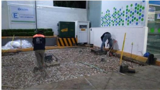
Se reparo el sistema de tierras y las tuberías dañadas por la excavación, se hizo el pozo de absorción requerido por m2 y se continuó excavando y compactando.
