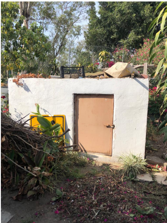
Imagen 45. Fotografía propia. Vista del cuarto de tinaco..
