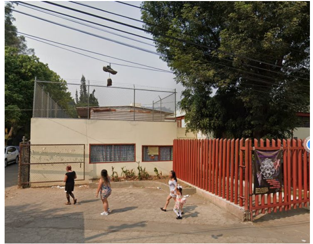
Imagen 19. Imagen de Google Maps 2022. Vista a la fachada lateral del Centro de Desarrollo Social Santa Cruz Acalpixca
