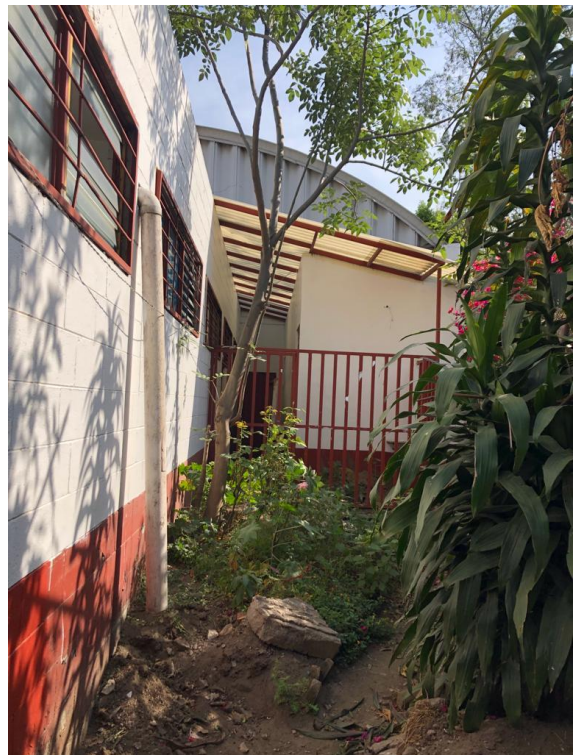
Imagen 46. Fotografía propia. Vista del jardín hacia los sanitarios.
