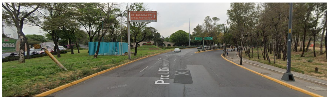
Imagen 36. Imagen de Google Maps 2022. Vialidad Prolongación División del Norte, lado del Centro de Desarrollo Social la Cebada.
