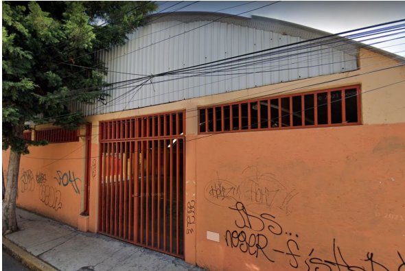
Imagen 22. Imagen de Google Maps 2022. Vista a la fachada del Centro de Desarrollo Social Oasis
