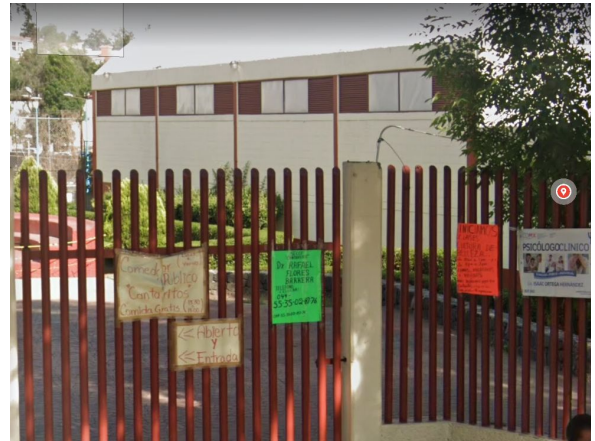
Imagen 15. Imagen de Google Maps 2022. Vista a la fachada lateral del Centro de Desarrollo Social Cantaritos
