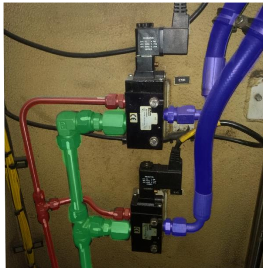
Figura 55. Circuito neumático de la electroválvula. (Hernández, J. 2022).
