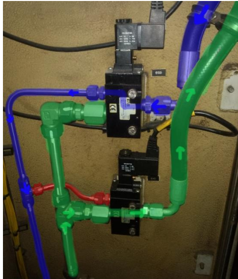
Figura 56. Función de electroválvula como apertura de puertas. (Hernández, J. 2022).
