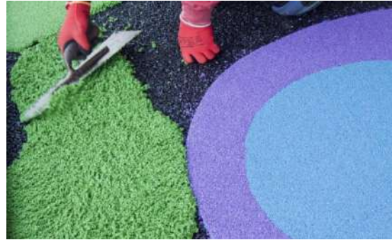
Imagen 79. Ejemplo ilustrativo colocación de aglomerado de caucho en sitio
