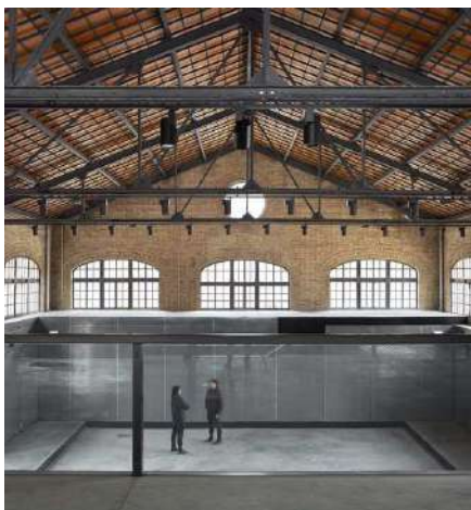
Imagen 57. Interior Nave 3 Parque Central, Valencia. Fuente: ©Mariela Apollonio
