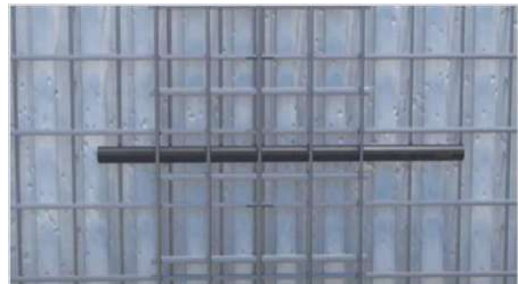
Imagen 62. detalle unión de panel en esquina, Fuente: E book instalación panel constructivo horizonpanel pag.4
