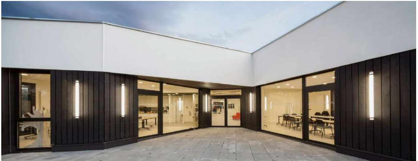
Imagen 12. Fotografía vista que hay desde un patio hacia la zona de talleres del Centro Comunitario en Billére Fuente: Adriá Goula
