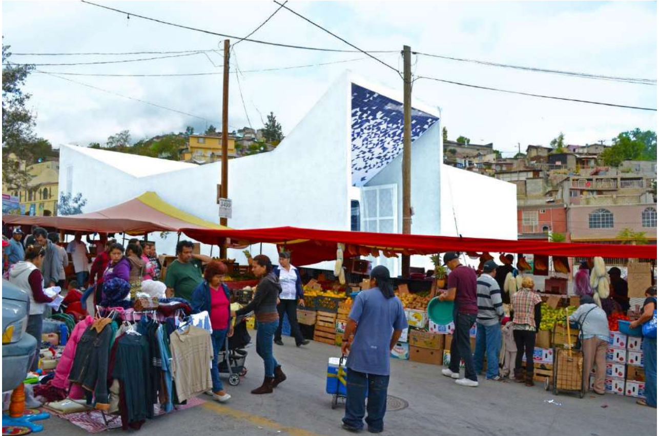
Imagen 26. Fotografía Biblioteca Casa de las Ideas donde se muestra el edificio con su contexto socio cultural y económico inmediato Fuente: CROstudio, Arturo González.
