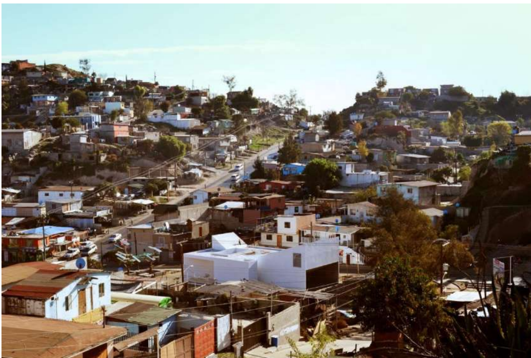
Imagen 23. Fotografía Biblioteca Casa de las Ideas donde se muestra el edificio con su contexto inmediato Fuente: CROstudio , Arturo González.
