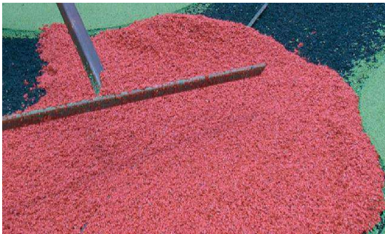
Imagen 78. Ejemplo ilustrativo colocación de aglomerado de caucho en sitio
