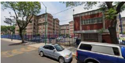
Imagen 3. Unidad Habitacional en la colonia Atlampa Fuente: Google maps Street view
