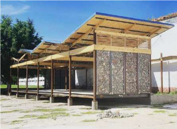
Imagen 46. Primera etapa del proyecto Centro Comunitario “La Perseverancia”
