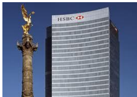
Figura 1.2 Edificio sede de HSBC en la Ciudad de México
