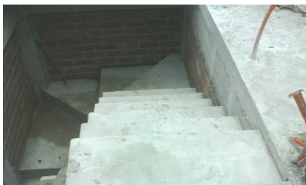
Imagen 35. Proceso de obra, descimbrado de escaleras, Autoría propia.
