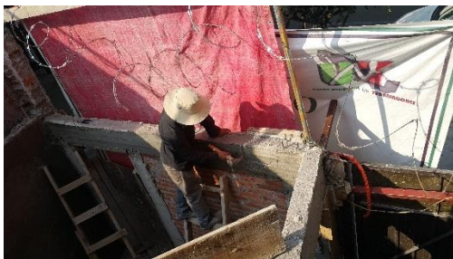
Imagen 79. Construcción de trabe en fachada principal. Autoría propia
