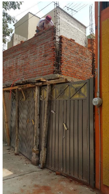
Imagen 81. Construcción de muros de planta alta de baño principal. Autoría propia
