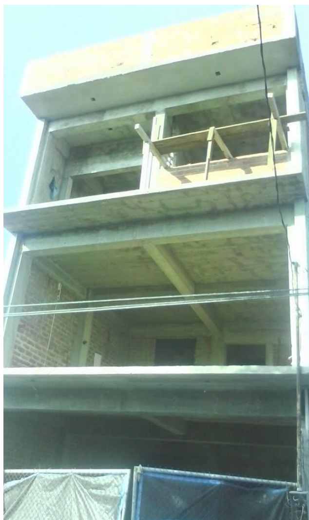
Imagen 36. Proceso de obra, obra negra terminada, lista para inicio de acabados, Autoría propia.
