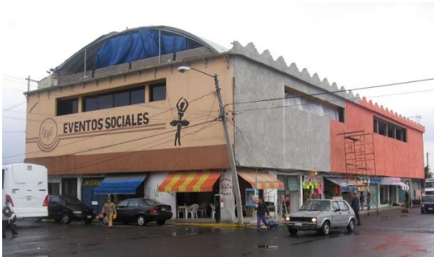
Imagen 13. Vista exterior del inmueble al inicio de los trabajos. Autoría propia
