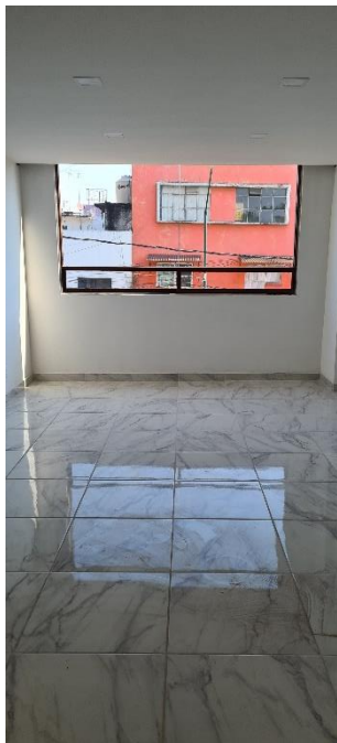
Imagen 100 al 105. Acabados en área de oficinas p.a. Autoría propia.
