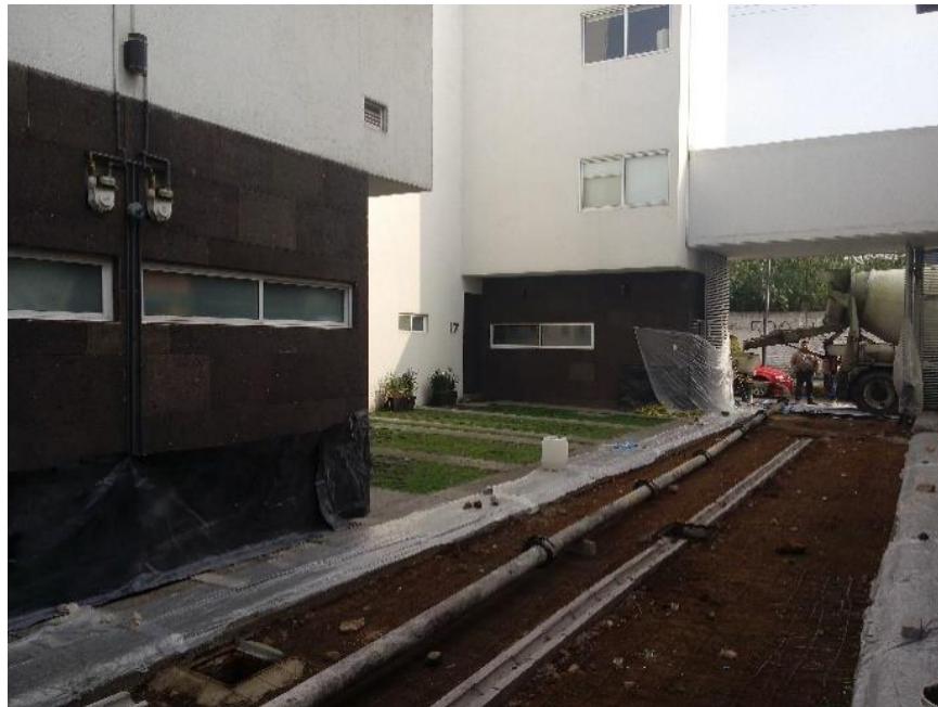
Imagen 45. Colado de concreto premezclado resistencia F'c=250\text{kg/cm}^2 reforzado con malla electrosoldada, previo nivelado y colocación de canal prefabricado central. Autoría propia.
