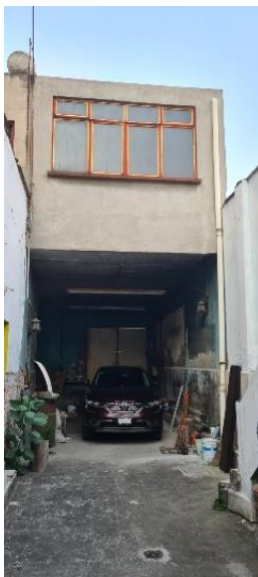
Imagen 87 y 88. Vistas del interior de la vivienda antes del inicio de los trabajos. Autoría propia.
