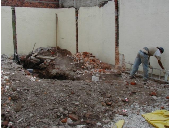
Imagen 7. Excavación de cepas. Autoría propia
