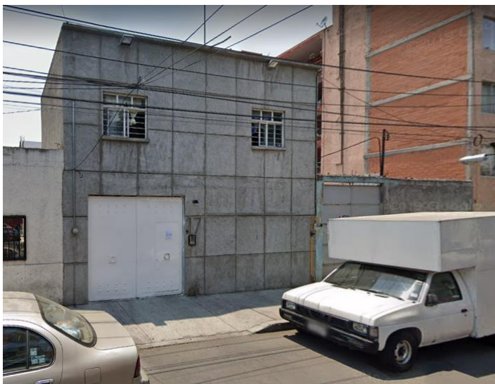
Imagen 1. Vista de acceso principal calle Efrén Rebolledo 17 (construcción existente). Autoría propia
