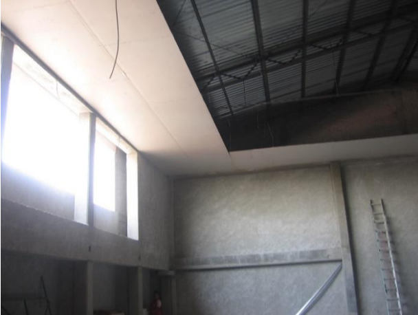
Imagen 21 y 22. Proceso de obra, fabricación de plafones salón principal. Autoría propia
