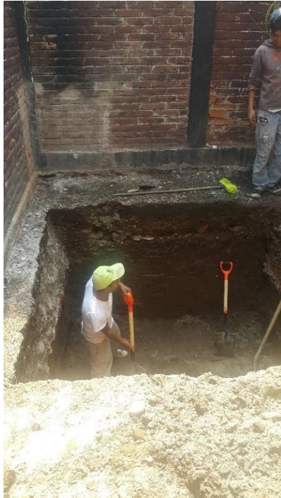
Imagen 76. Excavación en patio trasero para construcción de cisterna. Autoría propia
