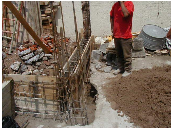
Imagen 8. Cimbrado de cimiento corrido. Autoría propia
