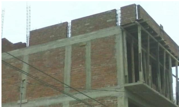
Imagen 34. Proceso de obra, construcción de muros de pretil en nivel azotea, Autoría propia.
