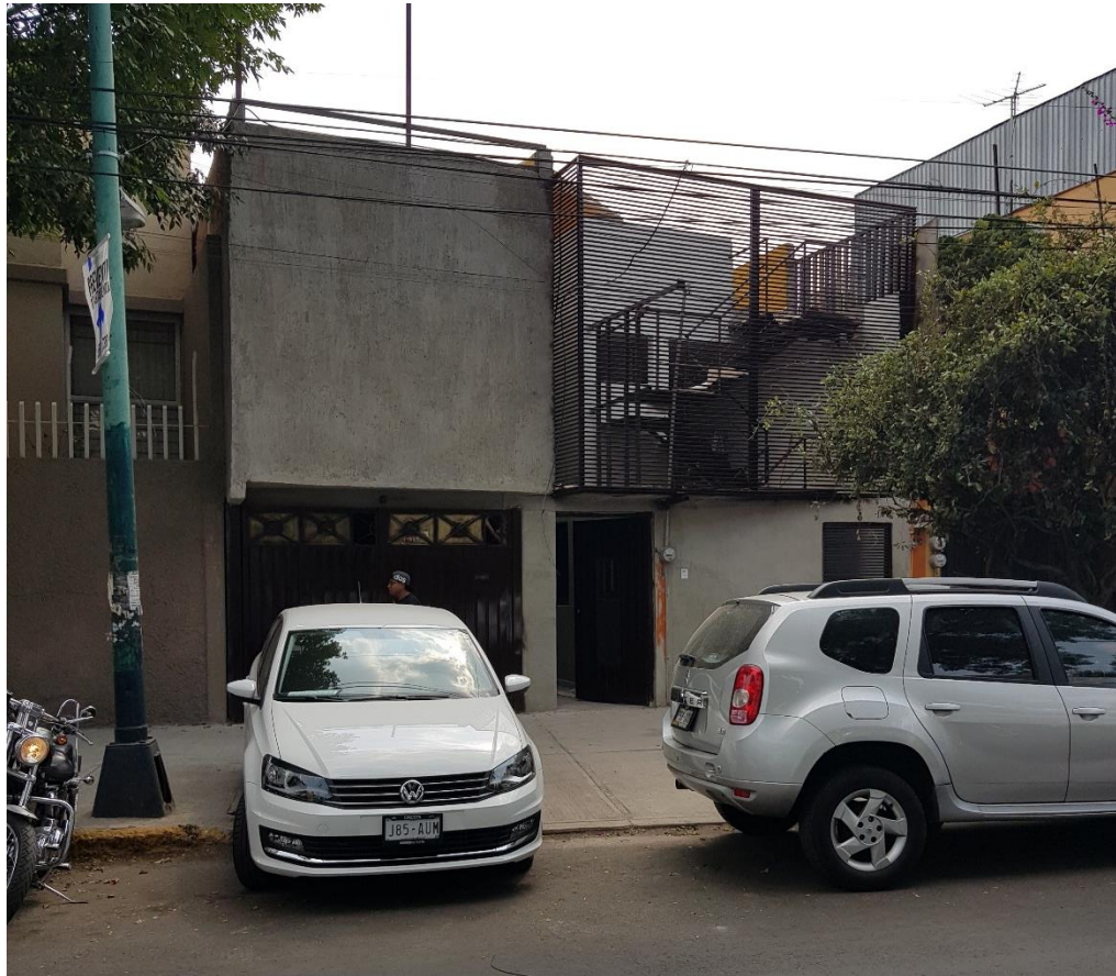
Imagen 83. Fachada principal terminada. Autoría propia.
