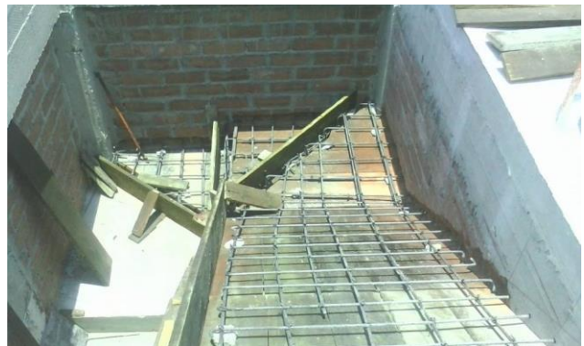
Imagen 33. Proceso de obra, cimbra y armado de escalera, Autoría propia.
