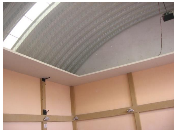
Imagen 21 y 22. Proceso de obra, fabricación de plafones salón principal. Autoría propia
