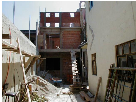
Imagen 10. Construcción de muros planta alta. Autoría propia
