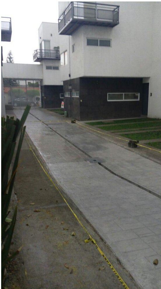
Imagen 47. Trabajo terminado. Autoría propia.
