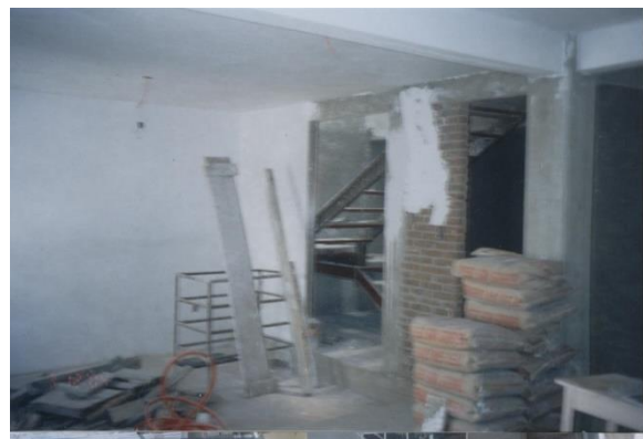
Imagen 11. Trabajos de enyesado en estancia planta baja. Autoría propia
