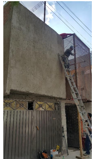
Imagen 82. Instalación de fachada de herrería para privacidad y seguridad. Autoría propia
