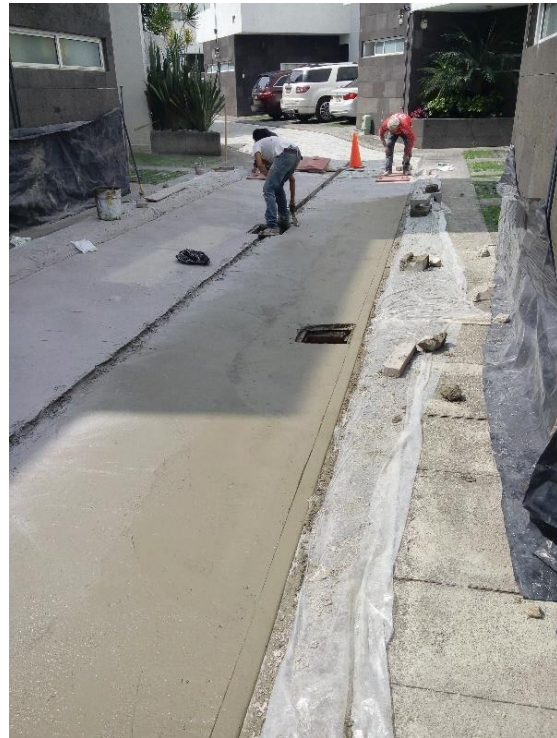
Imagen 46. Proceso de estampado del concreto en fresco. Autoría propia.
