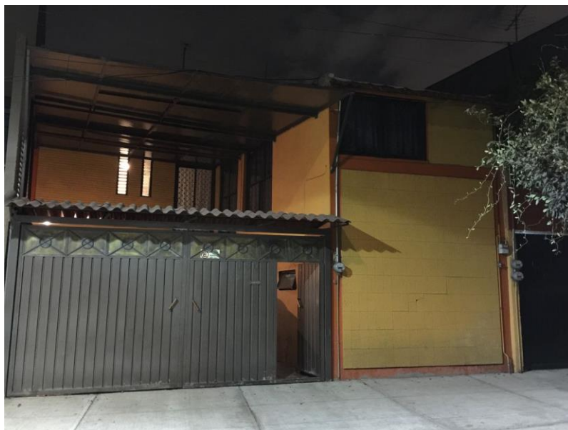
Imagen 67. Estado del inmueble antes de la intervención. Autoría propia
