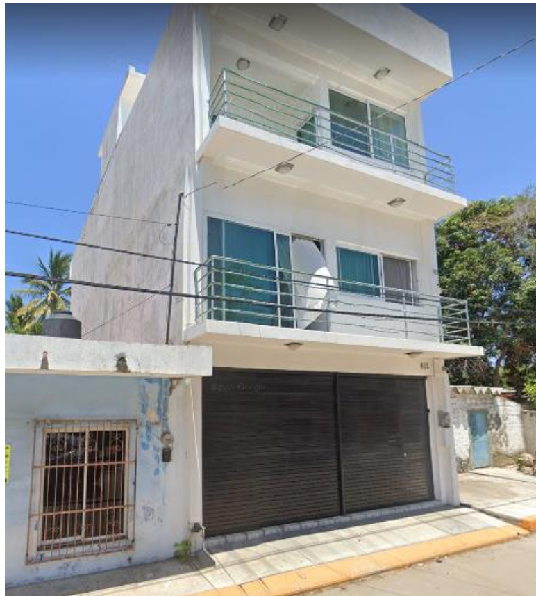
Imagen 39. Vista exterior obra terminada y en uso, Autoría propia.
