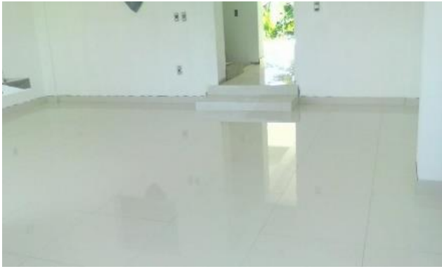
Imagen 37. Acabados terminados en piso y muros de planta alta, Autoría propia.
