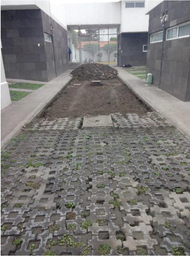
Imagen 43. Retiro de adopasto y excavación de 14 cm para colocar la cama de tepetate. Autoría propia.
