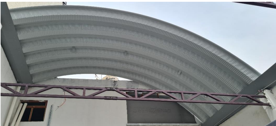
Imagen 97. Instalación de cubierta autosoportante. Autoría propia.
