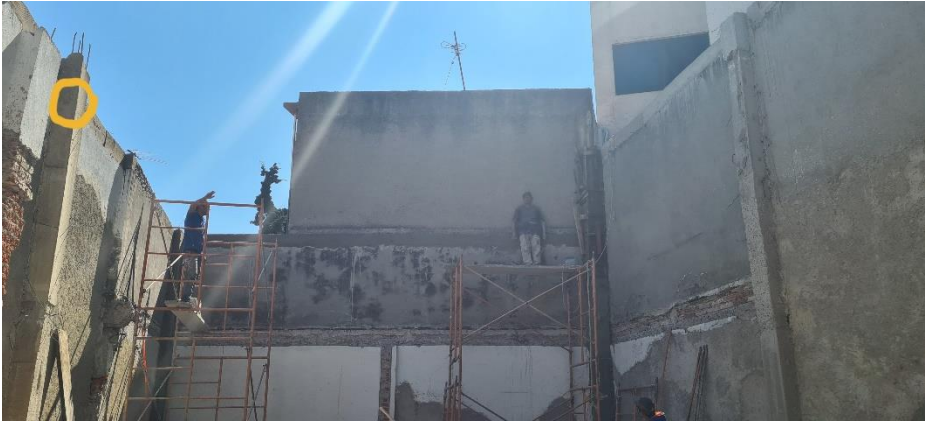
Imagen 95. Demolición de construcción interior. Autoría propia.
