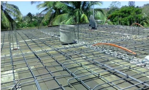
Imagen 32. Proceso de obra, cimbra y armado de losa de azotea, Autoría propia.
