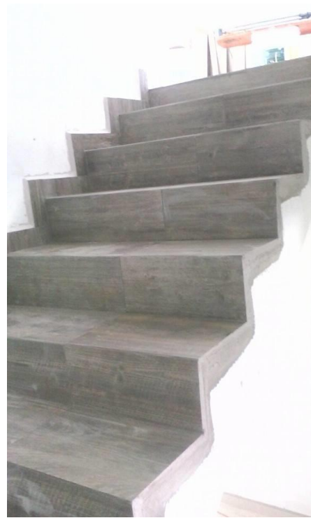
Imagen 38. Acabados terminados en escaleras, Autoría propia.
