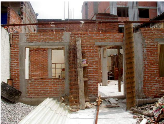
Imagen 9. Construcción de muros planta baja. Autoría propia
