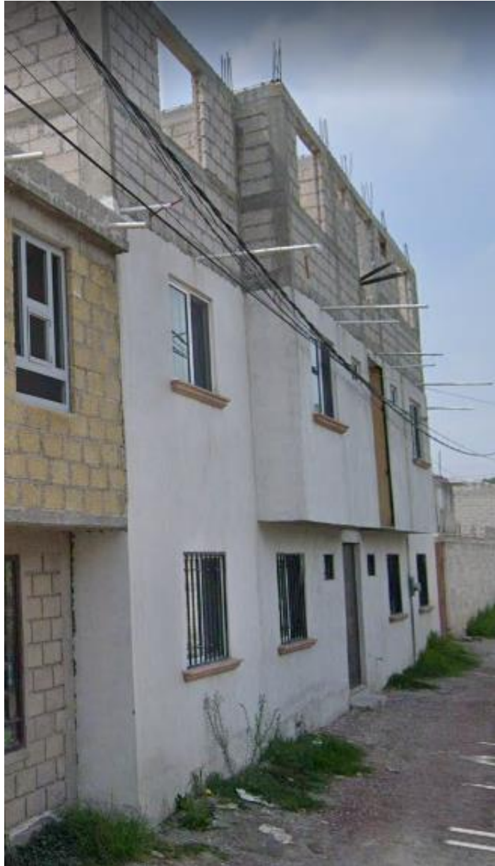
Imagen 65. Estado actual de la obra. Autoría propia.
