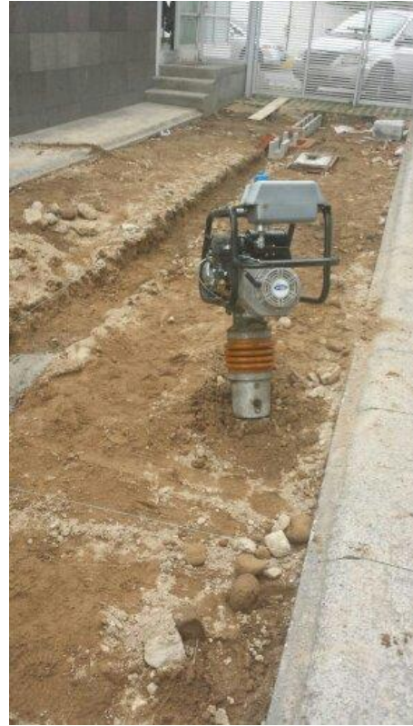
Imagen 44. Cama de tepetate compactado con bailarina de 14 cm. de esp. Autoría propia.
