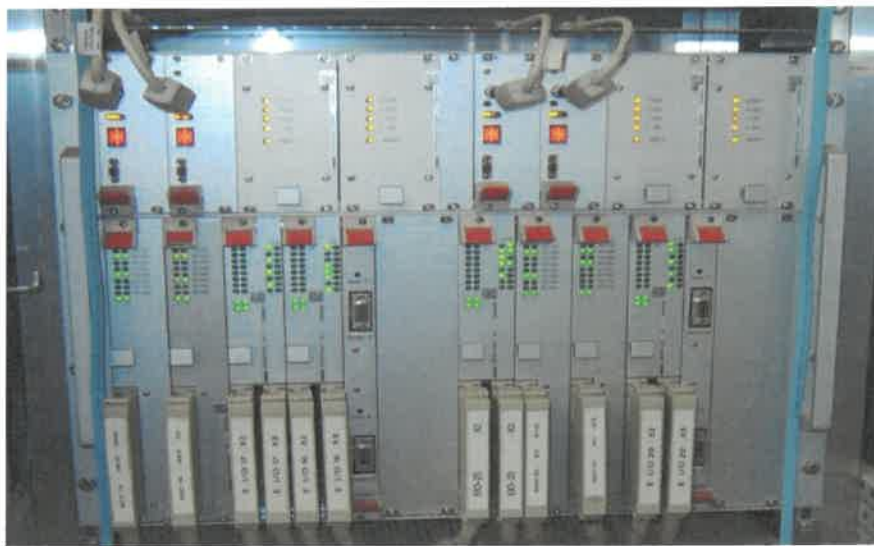
Fig. 2.6 Módulo de Control de Elementos (EC) en Armario
