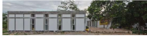
Figura 103. Fachada lateral de la Casa del Buen Samaritano de Lavalle + Peniche Arquitectos, Mérida, Yucatán, México. Fotografía: Onnis Luque, 2015. Autor: Mely Morfin, 2016.
