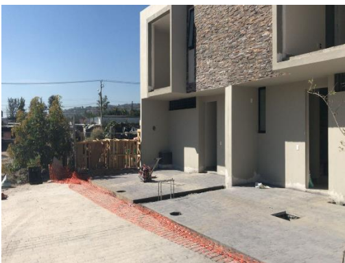
Imagen acabado de concreto, autor Raymundo Miranda, residente de obra, 06 de noviembre 2019
