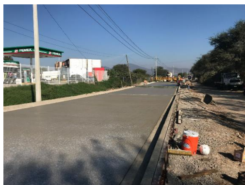
Imagen vialidad nivelada , autor Ulises Romero, residente de obra, 20 de abril de 2018
