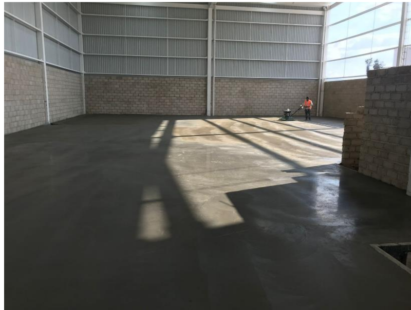
Acabado pulido de losa de concreto, autor Ulises Romero, residente de obra , 01 de septiembre de 2020
