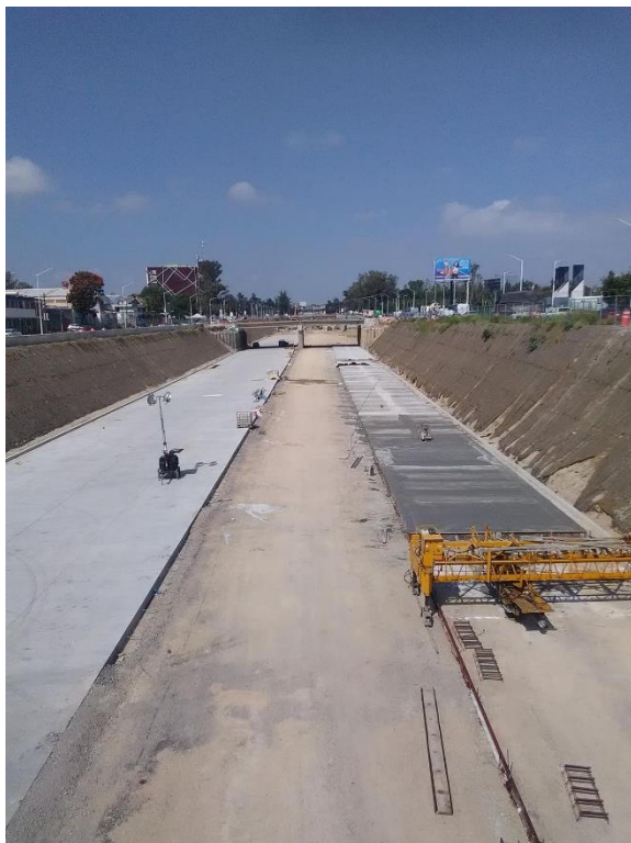
Imagen vialidad en proceso, autor Ulises Romero, residente de obra, 22 de abril de 2018
