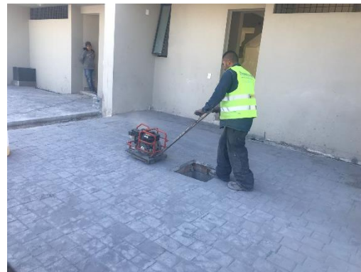
Imagen corte de losa en seco de concreto, autor Raymundo Miranda, residente de obra, 05 de noviembre 2019
