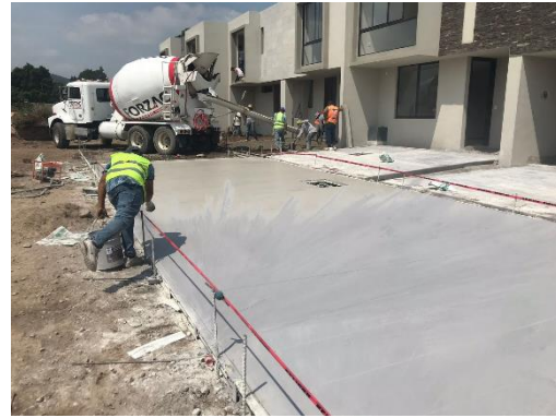
Imagen aplicación cemento para acabado de concreto, autor Raymundo Miranda, residente de obra, 03 de noviembre 2019
