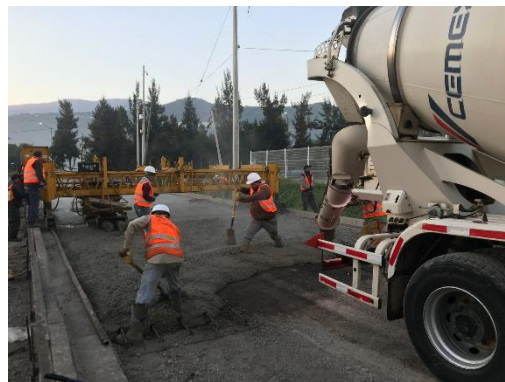
Imagen colocación de concreto, autor Ulises Romero, residente de obra, 20 de abril de 2018
