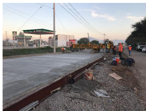
Imagen nivelación de concreto, autor Ulises Romero, residente de obra, 20 de abril de 2018
