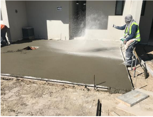
Imagen aplicación de color a concreto, autor Raymundo Miranda, residente de obra, 03 de noviembre 2019
