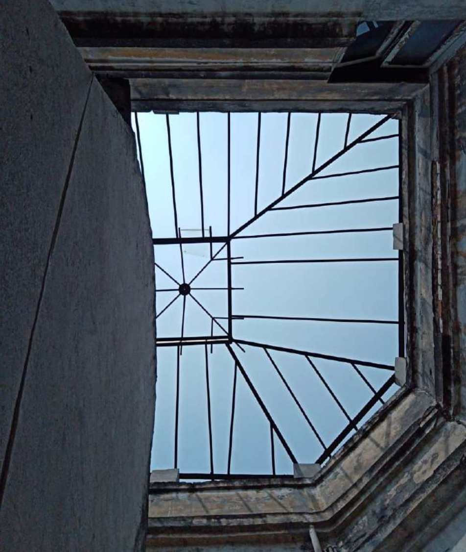
● ..... IMAGEN 27. Domo de herrería de 6 lados. Dos de sus extremos son inclinados. Se encuentra arriba de circulación vertical.
