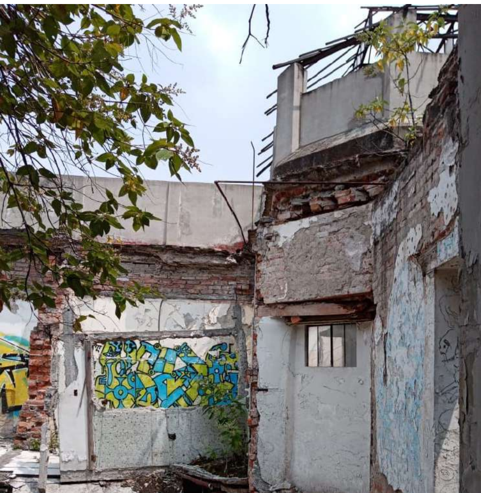
● ..... IMAGEN 28. Vista de Domo y vanos del interior de la casona.
