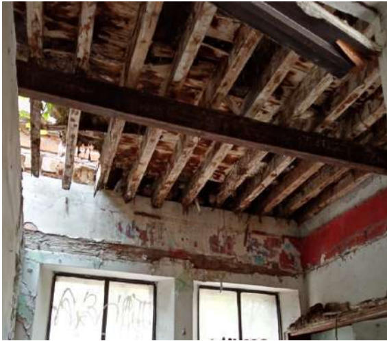
IMAGEN 29. Interior Casona, Cubierta 1.
