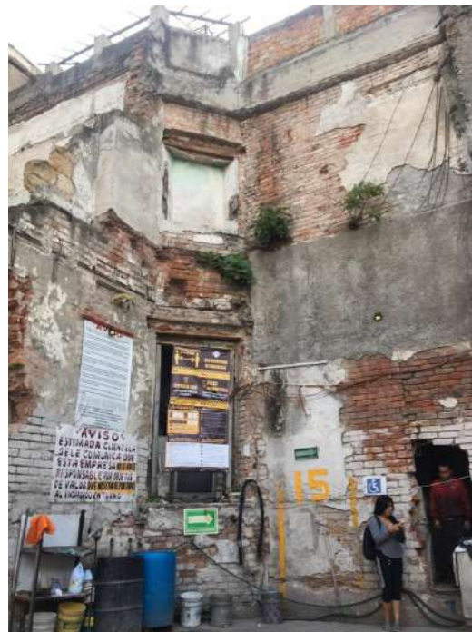
IMAGEN 21. Acceso actual a única circulación vertical, casona.
