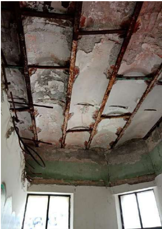
IMAGEN 31. Interior Casona, Cubierta 2.
