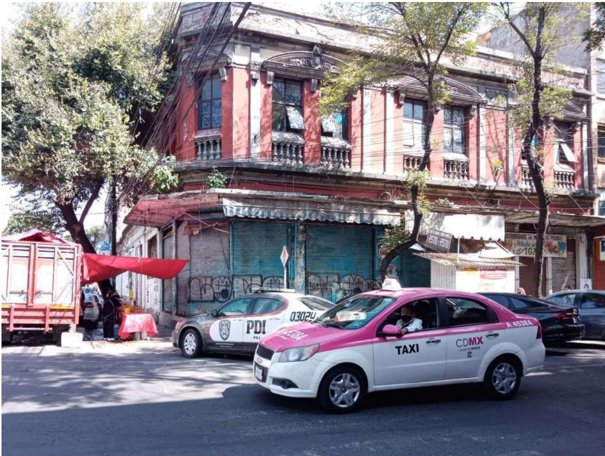
IMAGEN 22. Fachada principal compuesta por cortinas para el uso de negocios. Actualmente no están en funcionamiento.
