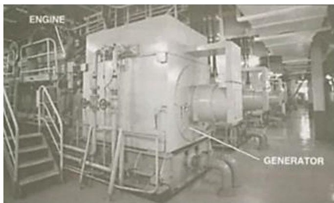
Figura 11. Motor más generador (Introducción del equipo de perforación, Slumberguer. 2004).
