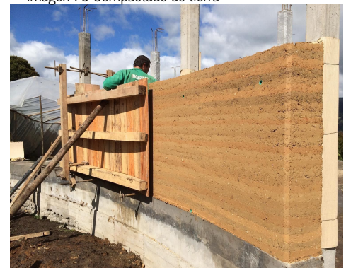
Imagen 77 Desencofrado del muro
