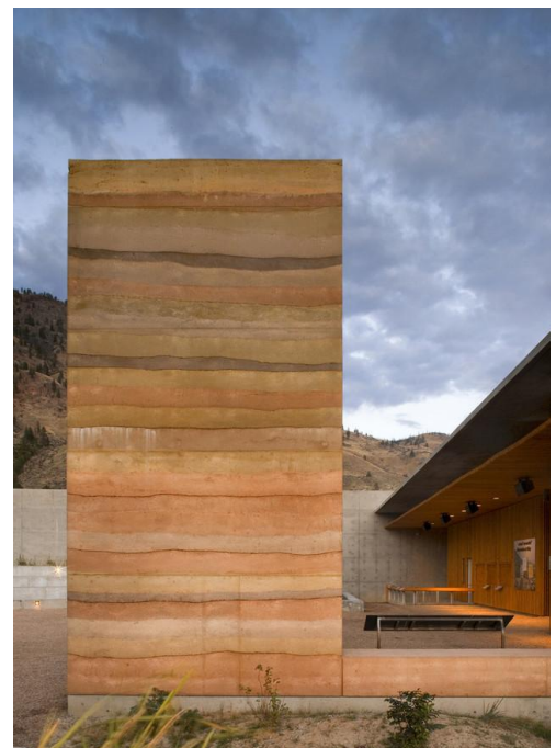
Imagen 72 y 73 Muros de tapial
