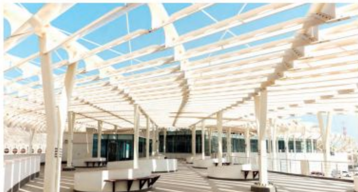
Imagen 28 Detalle cubierta. Snøhetta AS
