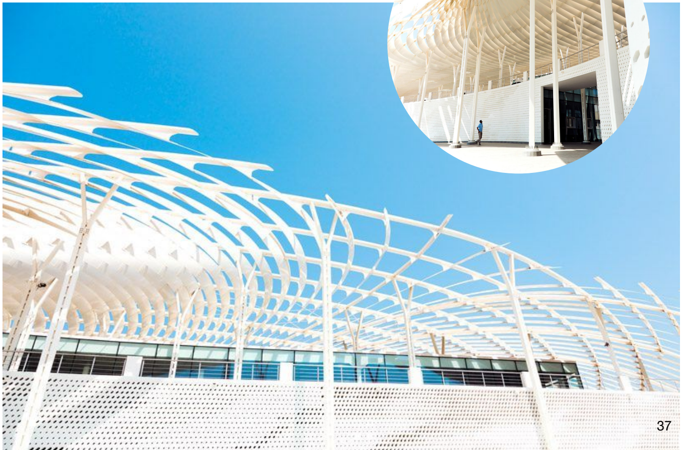
Imagen 30 Detalle cubierta. Snøhetta AS
