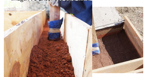
Imagen 76 Compactado de tierra
