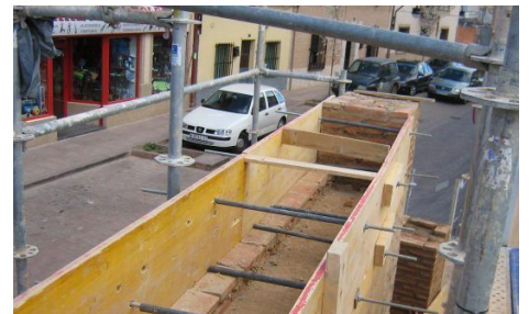
Imagen 75 Encofrado para tapial
