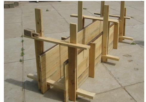
Imagen 74 Encofrado para tapial
