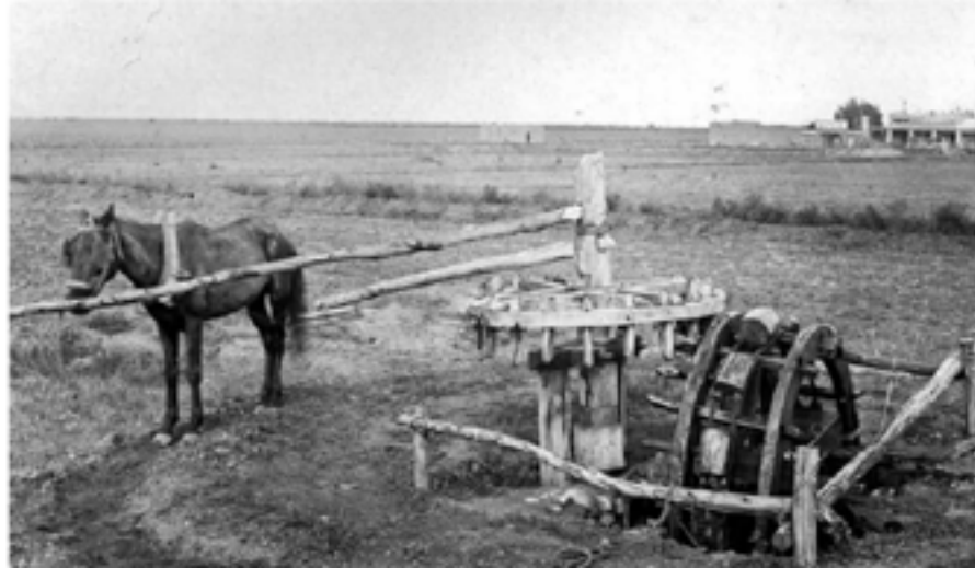
Figura 37. Noria horizontal movida por un caballo, empleada para irrigar.
