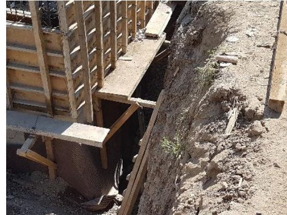
IMPERMEABILIZACIÓN DE CISTERNA
