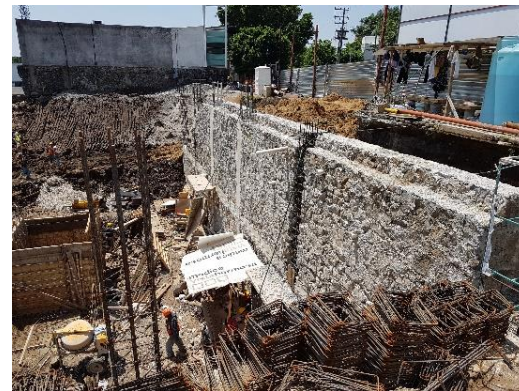
MURO DE CONTECIÓN PIEDRA (RIO PANUCO)
