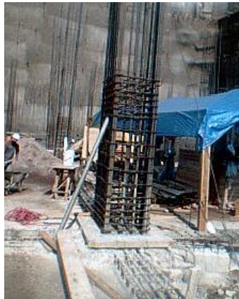
ARMADO DE COLUMNA
