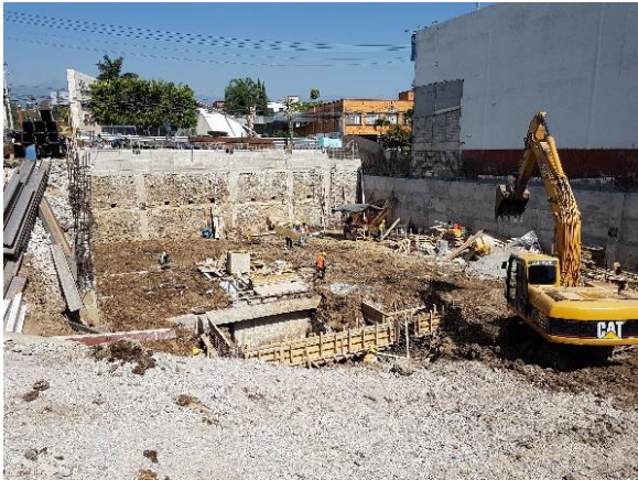
NIVELACIÓN DE TERRENO
