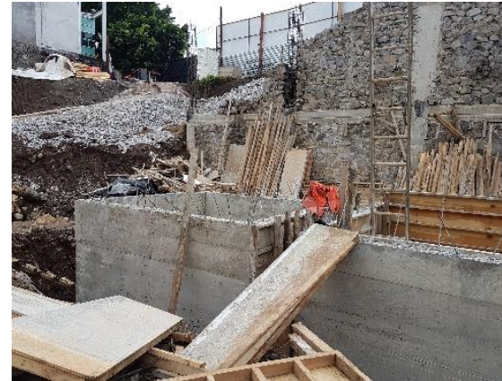
DESCIMBRADO DE CISTERNAS
