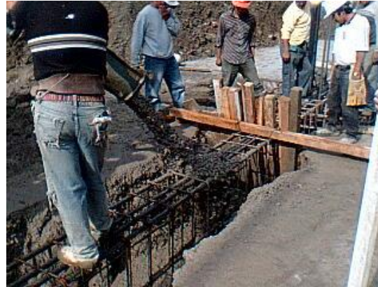
COLADO DE CONTRATRABE DE CIMENTACIÓN
