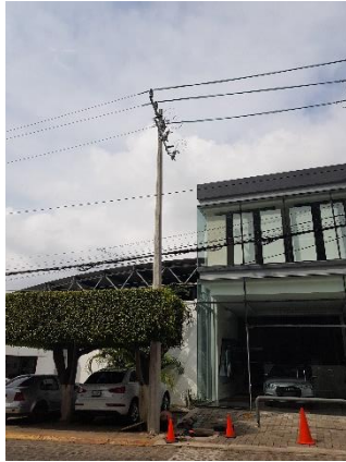
INSTALACIÓN DE POSTE Y REGISTRO
