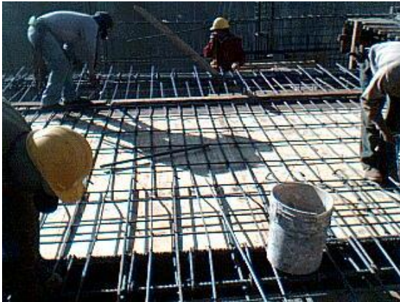
ARMADO DE LOSA (O #3 @30)
