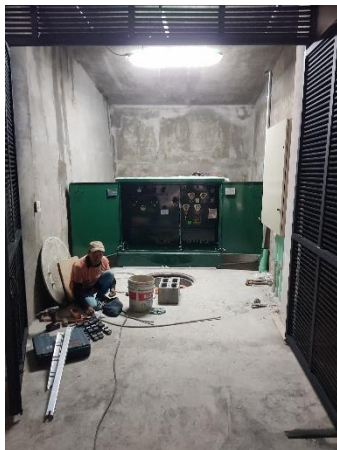
INSTALACIÓN DE TRASFOMADOR 500KVA
