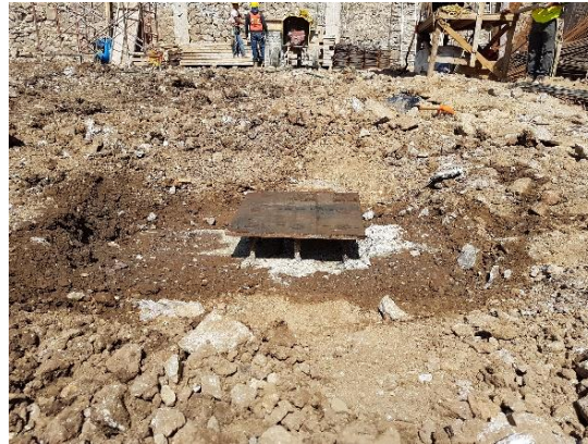
PREPARACION DE PLACA (DESPLANTE DE COLUMNA)
