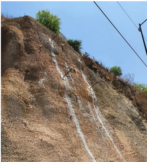
ESTABILIZACIÓN DE TALUD (AUTOPISTA)
