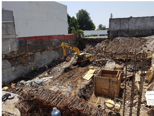
CIMBRA DE CISTERNA Y EXCAVACIÓN
