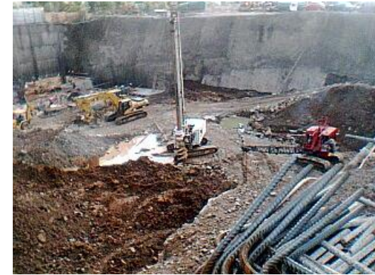
EXCAVACIÓN Y PREPARACIÓN DE PILAS
