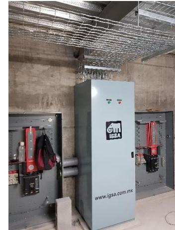
INSTALACIÓN DE TABLEROS I-LINE
