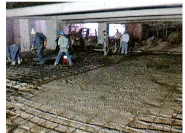
COLADO PISO S4
