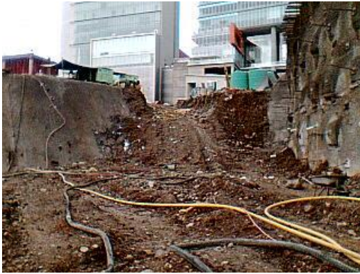
EXCAVACIÓN DE TERRENO
