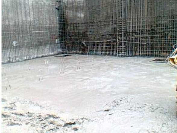
COLADO DE PLANTILLA CISTERNA
