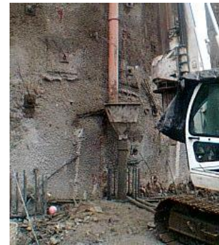
EXCAVACIÓN Y PREPARACIÓN DE PILAS
