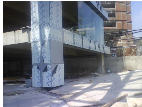
COLOCACIÓN DE PLACAS PARA BASTIDOR (FACHADA ALUCOBOND)
