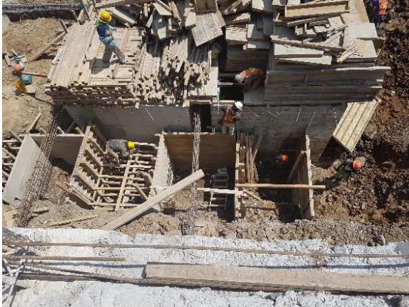
CIMBRA DE CISTERNAS DE AGUA POTABLE
