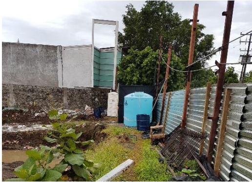
INSTALACIÓN DE TAPIAL
