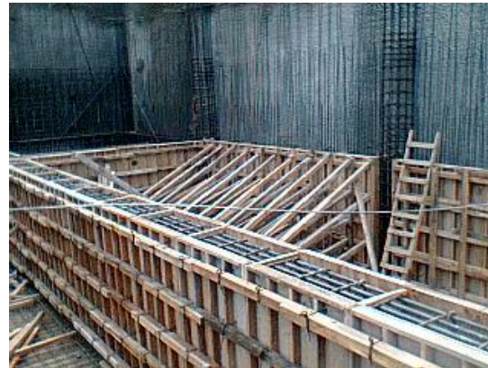
CIMBRA EN MURO DE CONTENCIÓN
