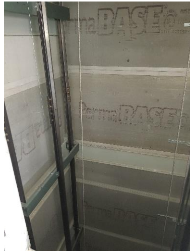
FORRO DE ESTRUCTURA (CUBO)
