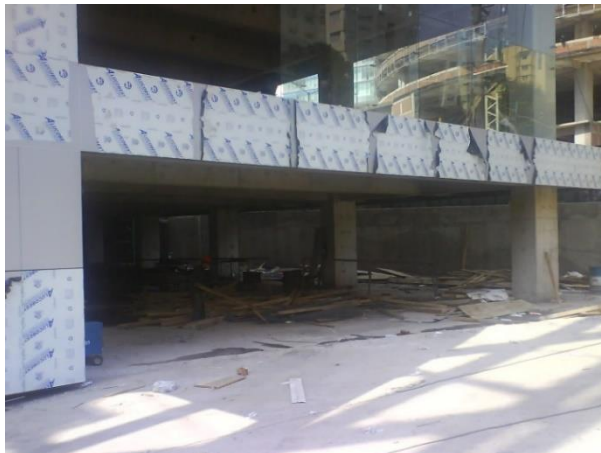
REVESTIMIENTO DE ESTRUCTURA
