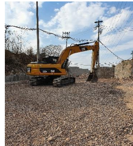
NIVELACIÓN DEL TERRENO
