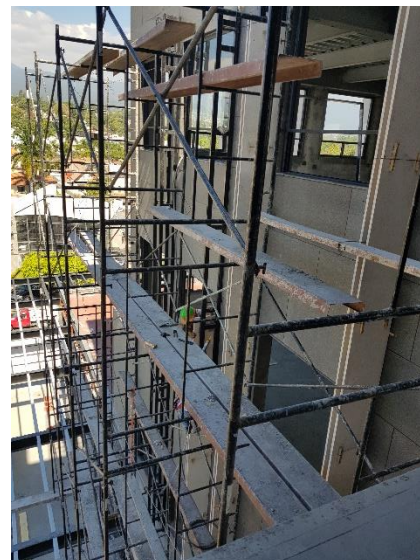
INSTALACIÓN DE GRANITO FACHADAS
