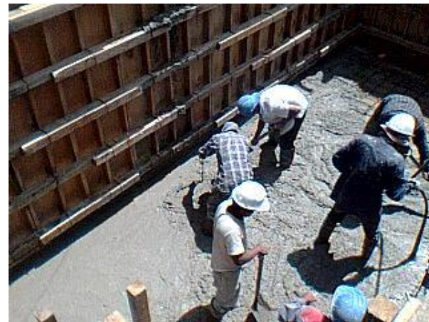
COLADO DE CISTERNA
