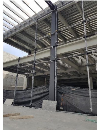
INSTALACION DE CANCELERIA EN FACHADAS
