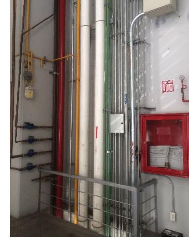
DUCTO DE INSTALACIONES
