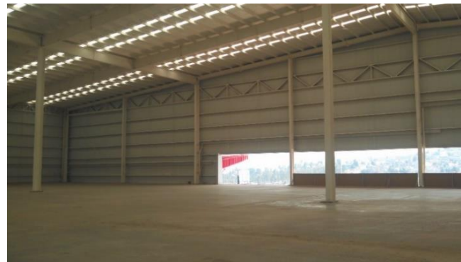
NAVE ESTRUCTURA METALICA
