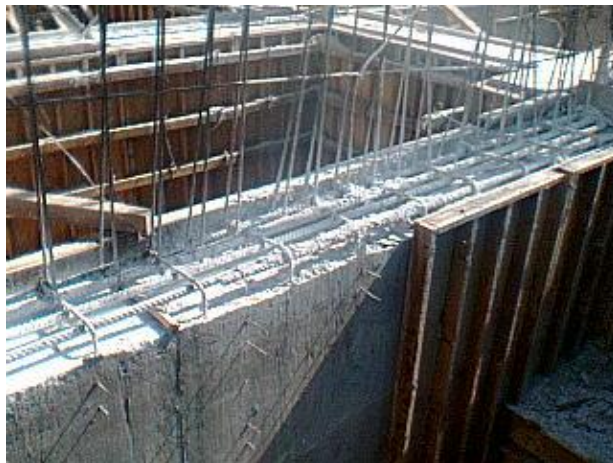
DESCIMBRADO DE MUROS
