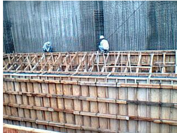
CIMBRA EN MUROS DE CISTERNA
