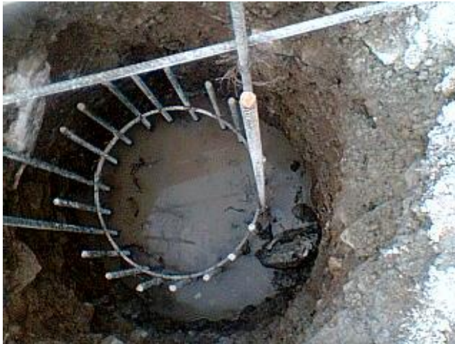
PILAS DE CIMENTACIÓN
