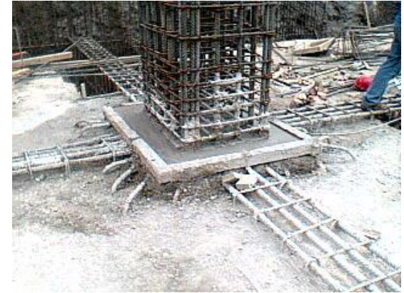
CONTRATRBAE Y ARMADO DE COLUMNA
