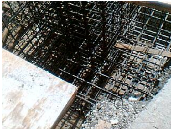
ARMADO DE CONTRATRABE
