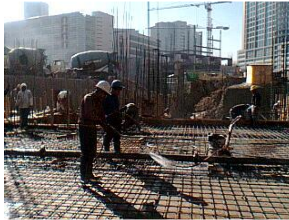
PREPARACIÓN DE LOSA PARA COLADO
