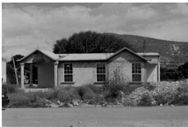
Imagen 55. "Nuevas formas en la construcción de viviendas." Autor: OLRA. 2012. Fuente: http://www.ub.edu.com.mx
