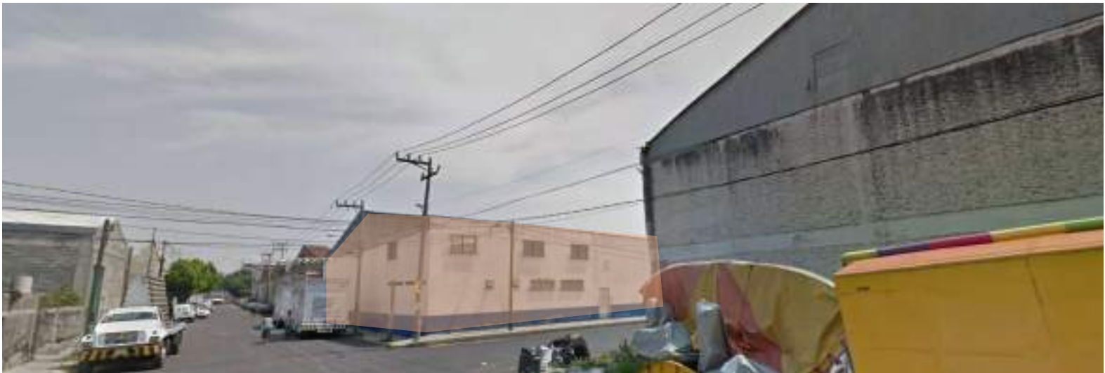
Imagen 106. "Esquina Nave Industrial." Elaboración propia con datos de Street View, de Google Maps, 2020.
