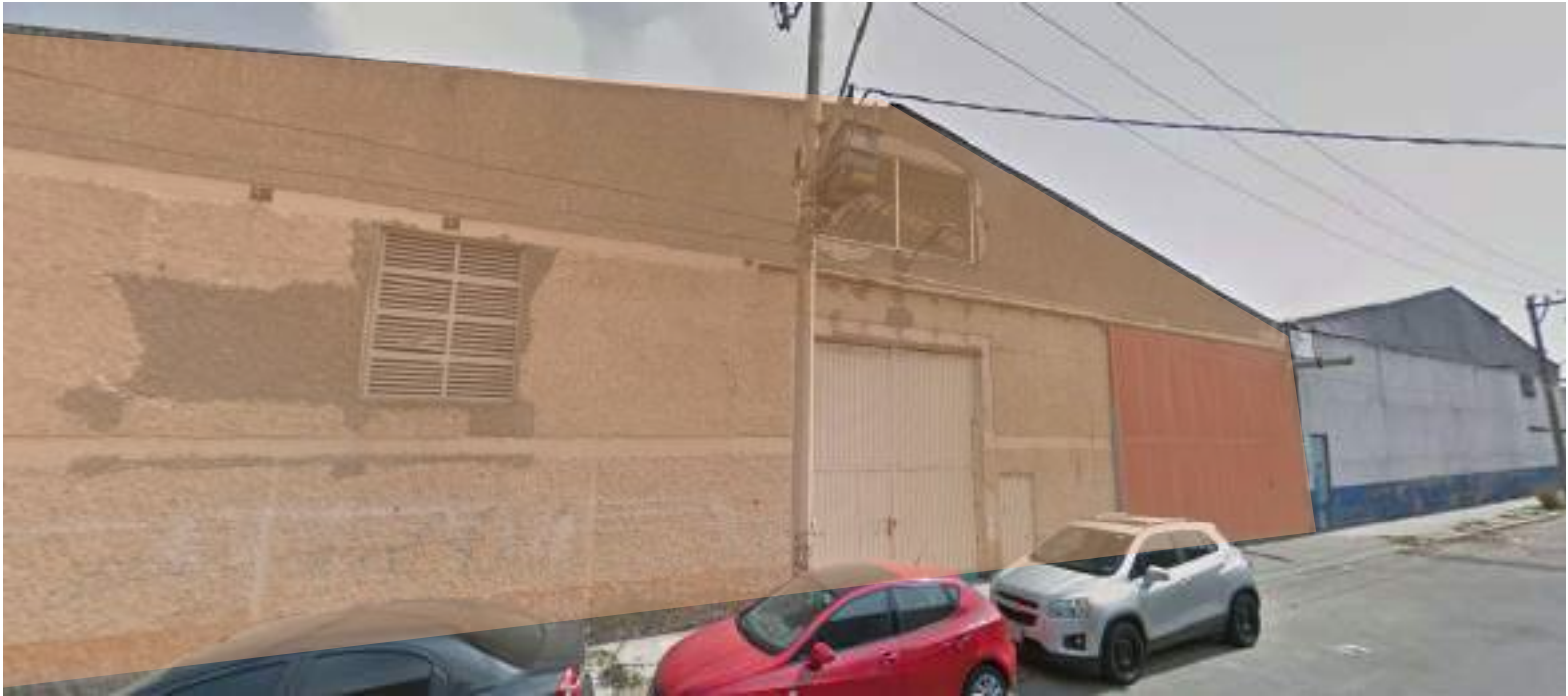
Imagen 105. "Nave Industrial." Elaboración propia con datos de Street View, de Google Maps, 2020.
