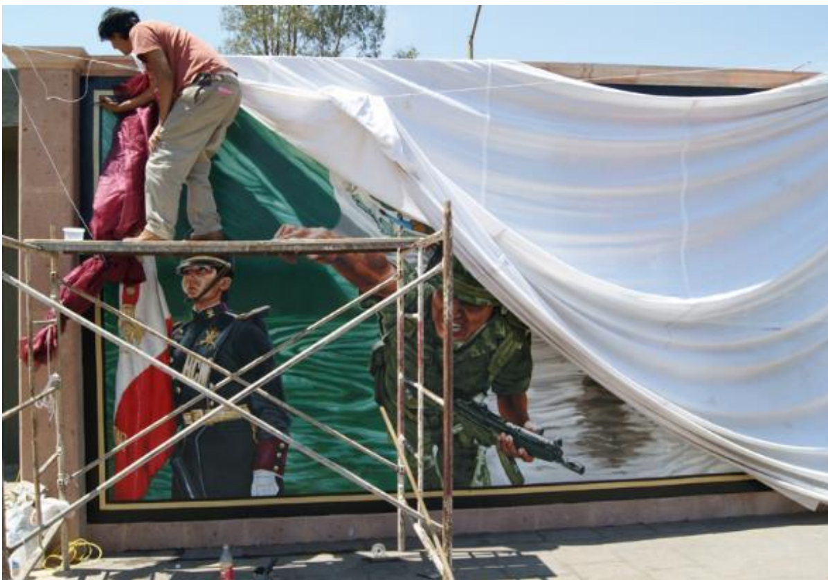
Ilustración 96. Vista de una parte del proceso del enmarcado del mural Profesión que ama y cuida la vida realizado por una empresa especializada en estructura metálicas y acero inoxidable, Unidad Académica de Enfermería de la Universidad Autónoma de Zacatecas, foto: José Arturo Ramos Pinedo, 2021.
