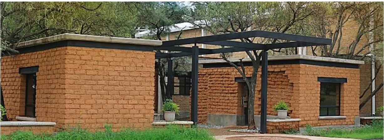
Ilustración 186: Referencia fotográfica de las aulas de Vitivinicultura de la UTNA, Foto: Miguel Alcántara 2019.
