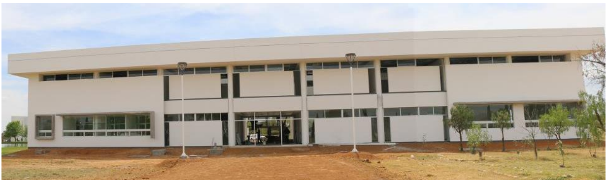
Ilustración 181: Vista general de la fachada norte del edificio G. foto: José Miguel Alcántara.
