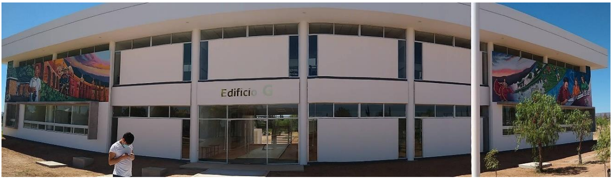
Ilustración 212: Vista panorámica deformada de la fachada norte del edificio G de la UTNA con el díptico mural Tecnología, tradición cultura y deporte en la educación superior . Foto: Imuris Aram Ramos Pinedo 2020.
