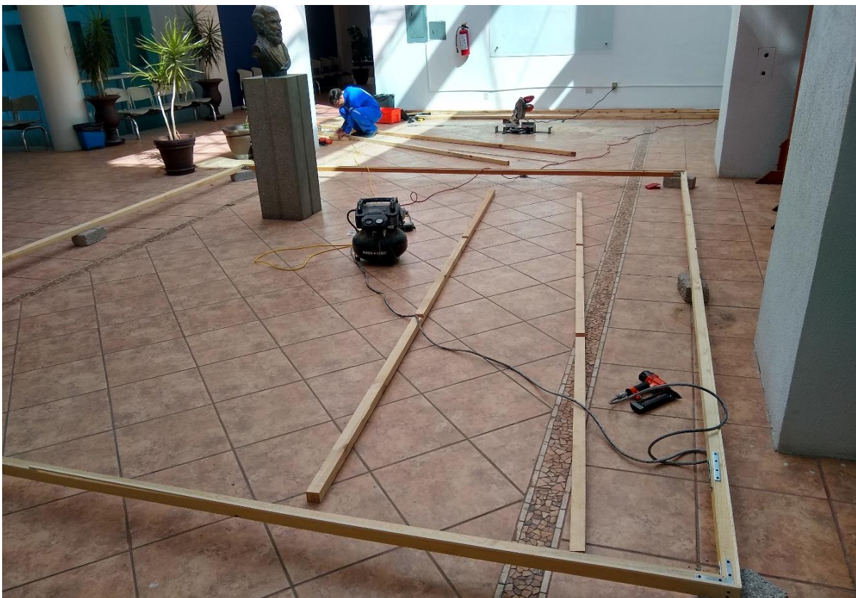
Ilustración 225: Construcción de la estructura de madera del bastidor para el mural Voluntad de vivir . Foto: Imuris Aram Ramos Pinedo, 2021.
