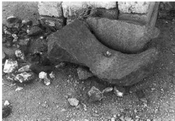
Figura 8. Molino de oro de forma cóncava con una piedra de molino de dos asas. (Klemm, 2001).
