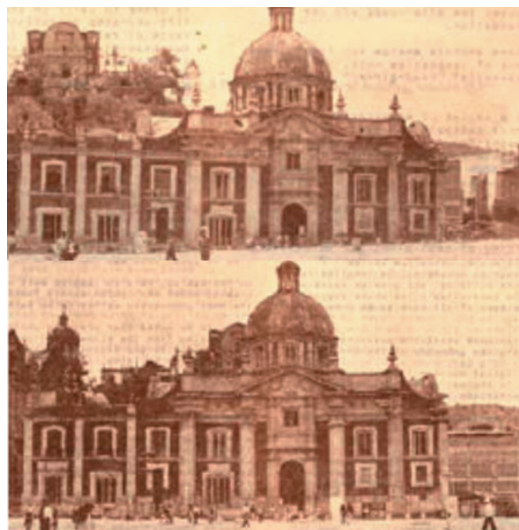
FIG. 16 Relación entre el hundimiento regional en el Centro Histórico y la extracción de agua del subsuelo del Valle de México (Tamez, 1992).
