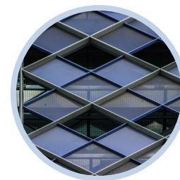
Trama de celosías que protegen la fachada del calor del sol
